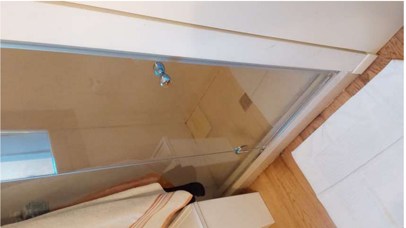
42_bagno 02 piano primo
