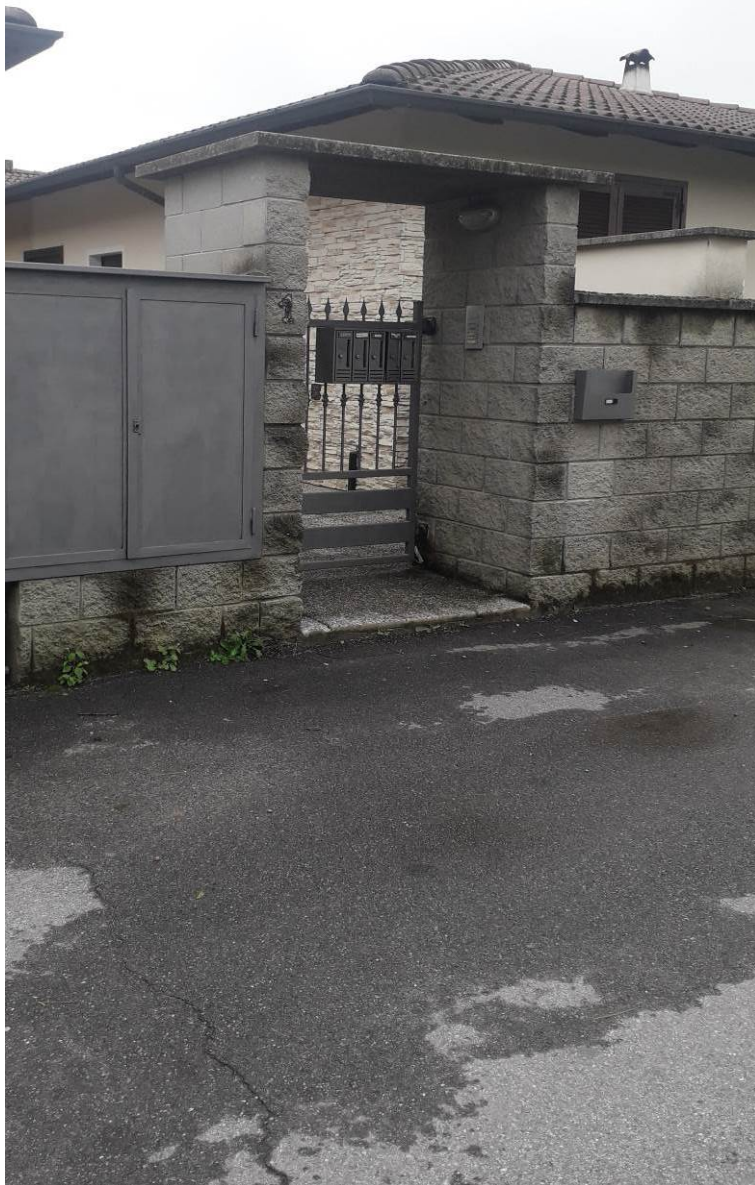
Ingresso pedonale comune
