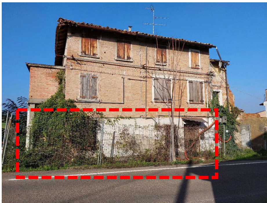
Prospetto est su Via Abetone Superiore
