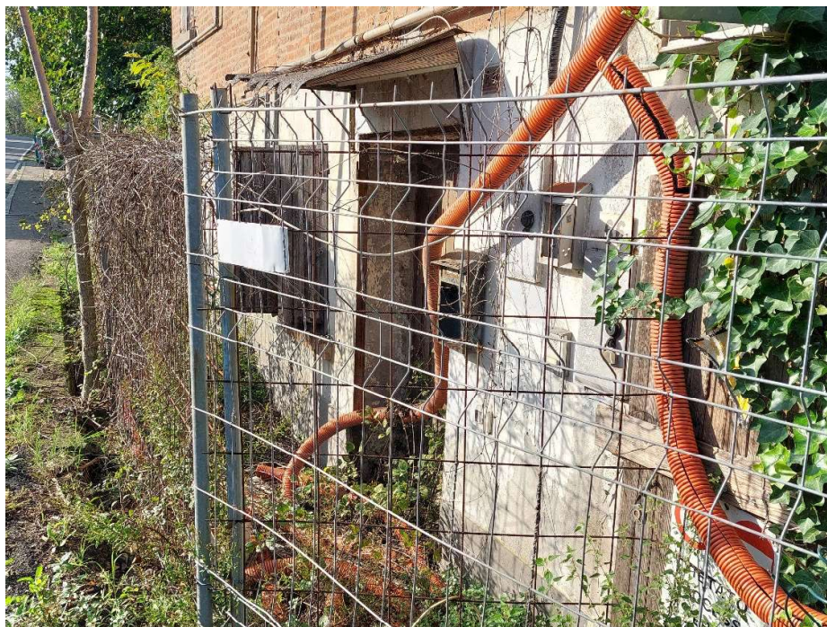
Particolare facciata porzione oggetto di analisi
