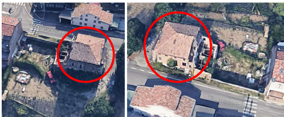
Viasta aerea del complesso
