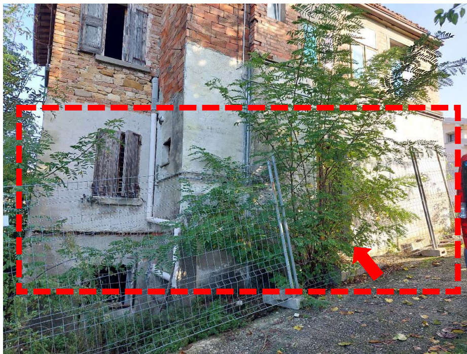
Facciata sud con ingresso all'unità oggetto di analisi
