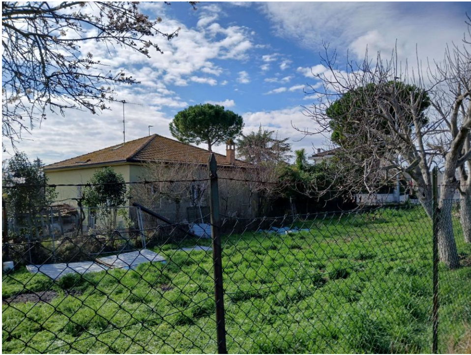
Corte esterna recintata ricadente all'interno del Lotto n.1
