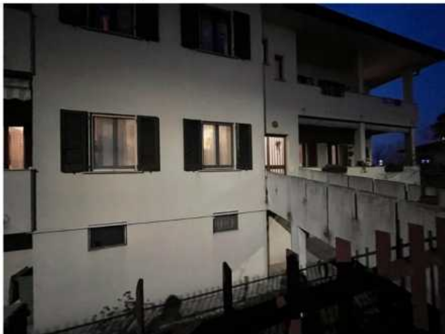
Immagine 2. Vista del fronte principale di accesso la sera del sopralluogo.
