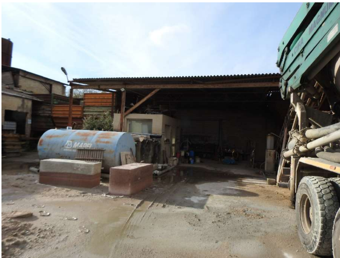
Figura 75 - Immobile 5 (tettoia operativa). Vista del prospetto principale.
