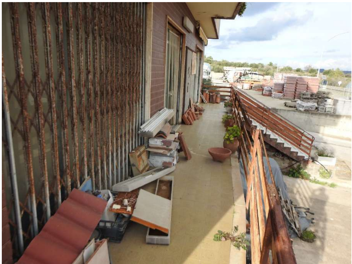
Figura 39 - Immobile 2 (negozi), balconata
