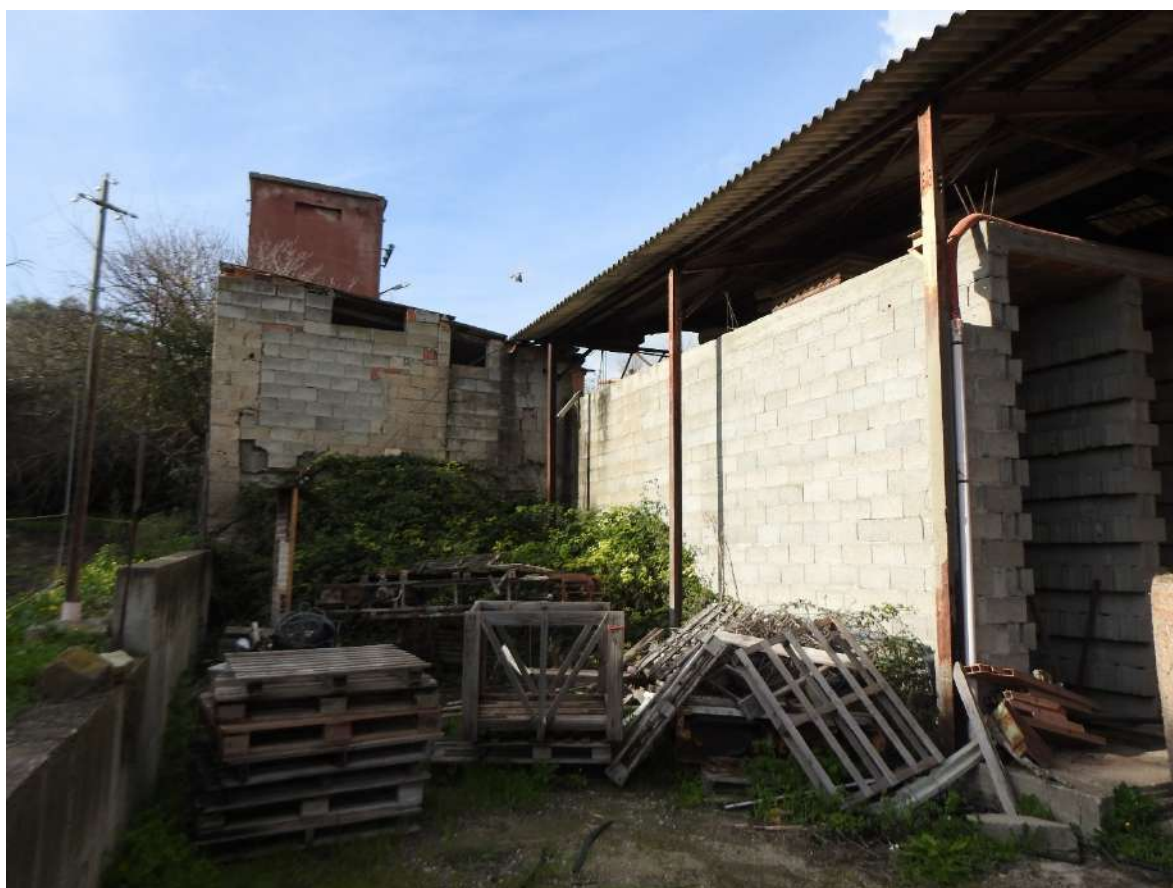
Figura 91 - Porcilaia. Visuale dal mappale 4365 verso la cabina elettrica. A sx il mappale 391 (estraneo alla procedura). A dx il blocco 4D (essicazione).
