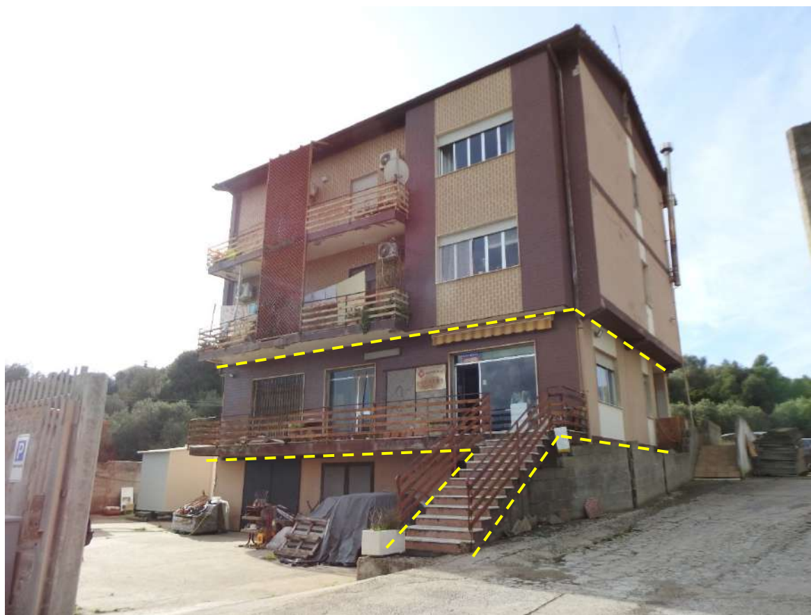
Figura 36 - Immobile 2 (negozio), ingresso principale e affaccio laterale
