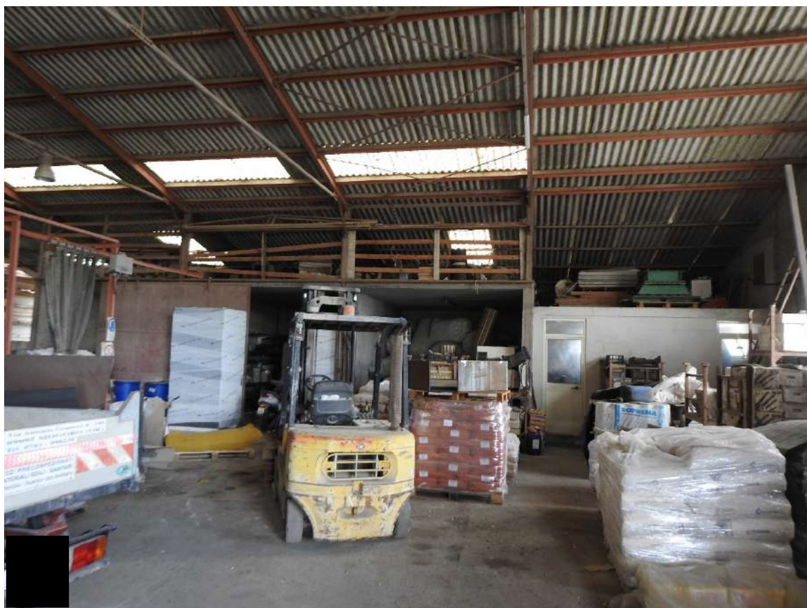
Figura 63 - Immobile 4 (capannone principale), blocco 4A. Visuale verso impianto di maturazione (a sx) e blocco servizi (a dx).
