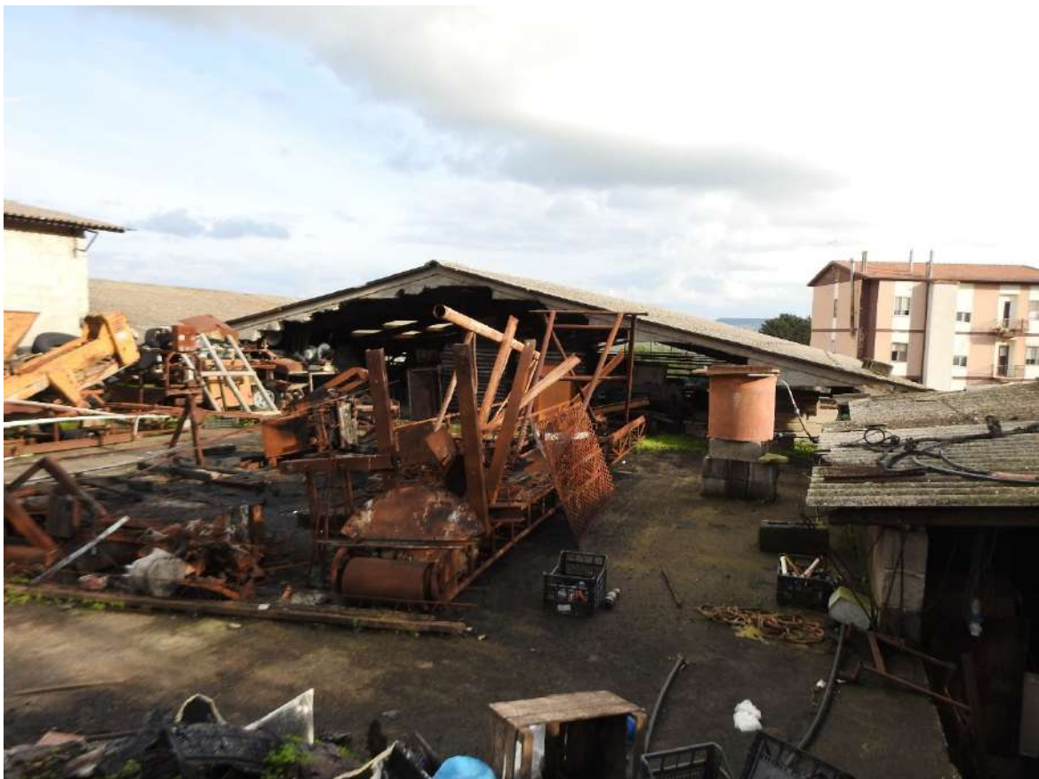
Figura 22 - Visuale della zona soprastante la zona essiccazione del capannone. In fondo a dx la palazzina. Di fronte il fabbricato di cui al punto 4 del pignoramento. Subito a destra la porcilaia.
