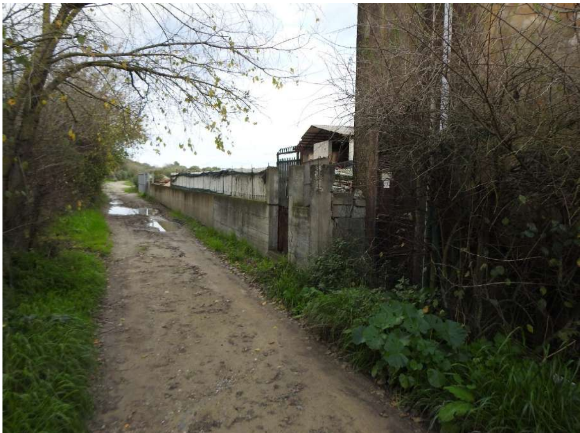
Figura 18 - Visuale da strada vecchia, da sud verso nord. A destra la cabina elettrica
