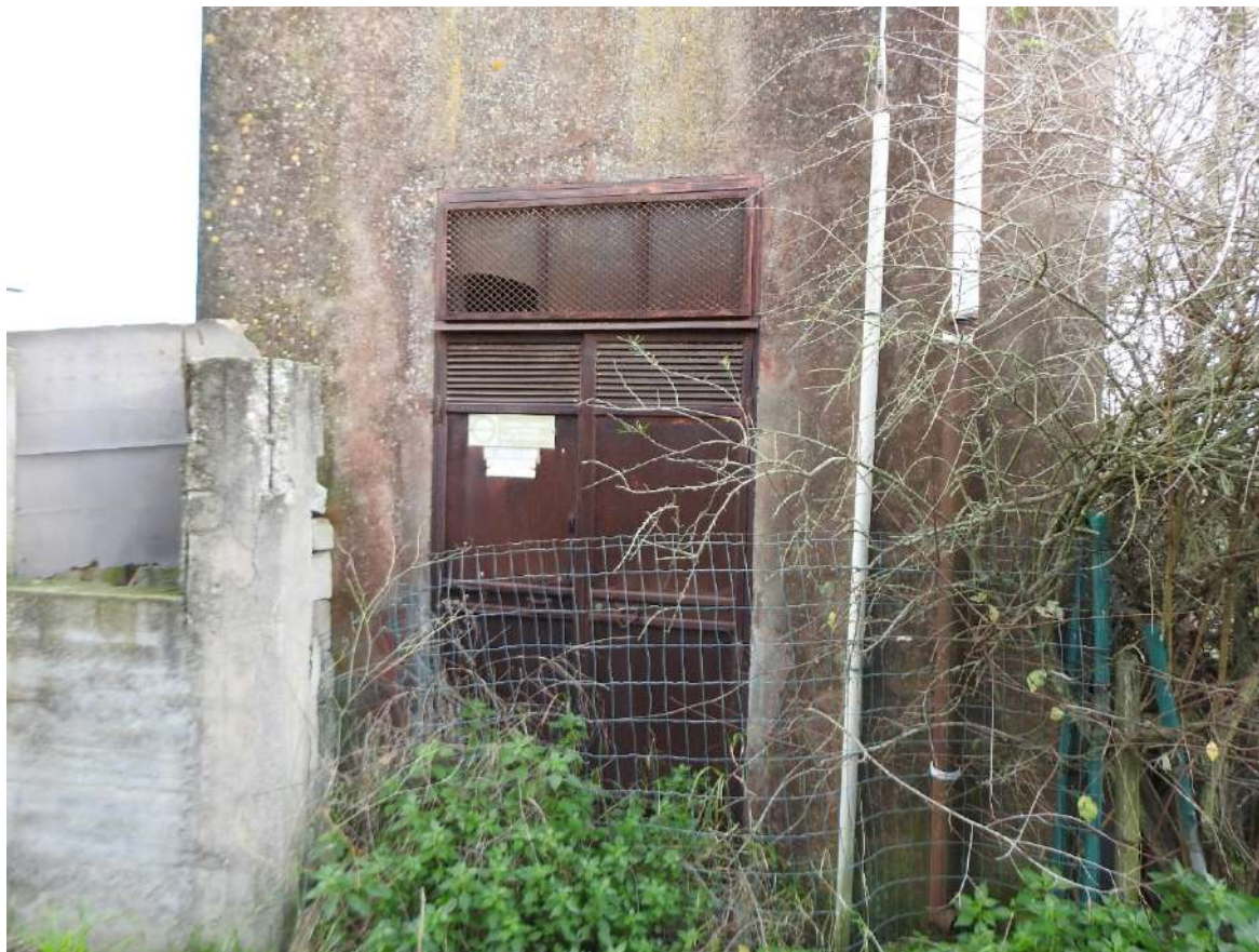
Figura 55 - Immobile 3 (cabina elettrica), ingresso
