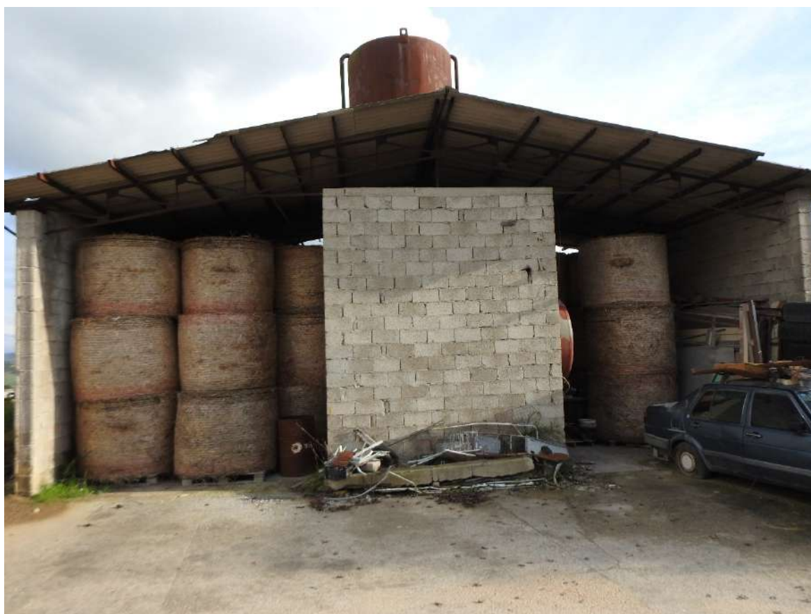
Figura 74 - Immobile 4 (capannone principale), blocco 4C.
