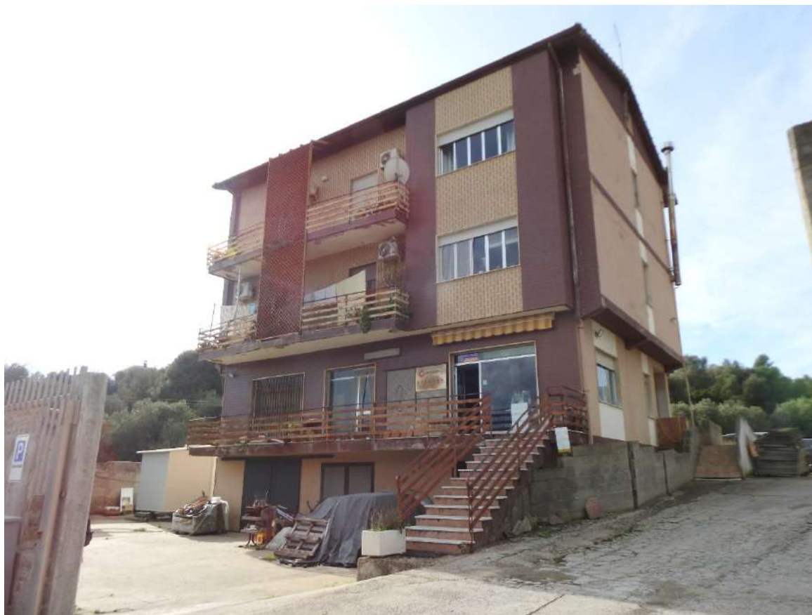
Figura 26 - Visuale della palazzina dal civico 349 – fronte principale a est e facciata laterale nord
