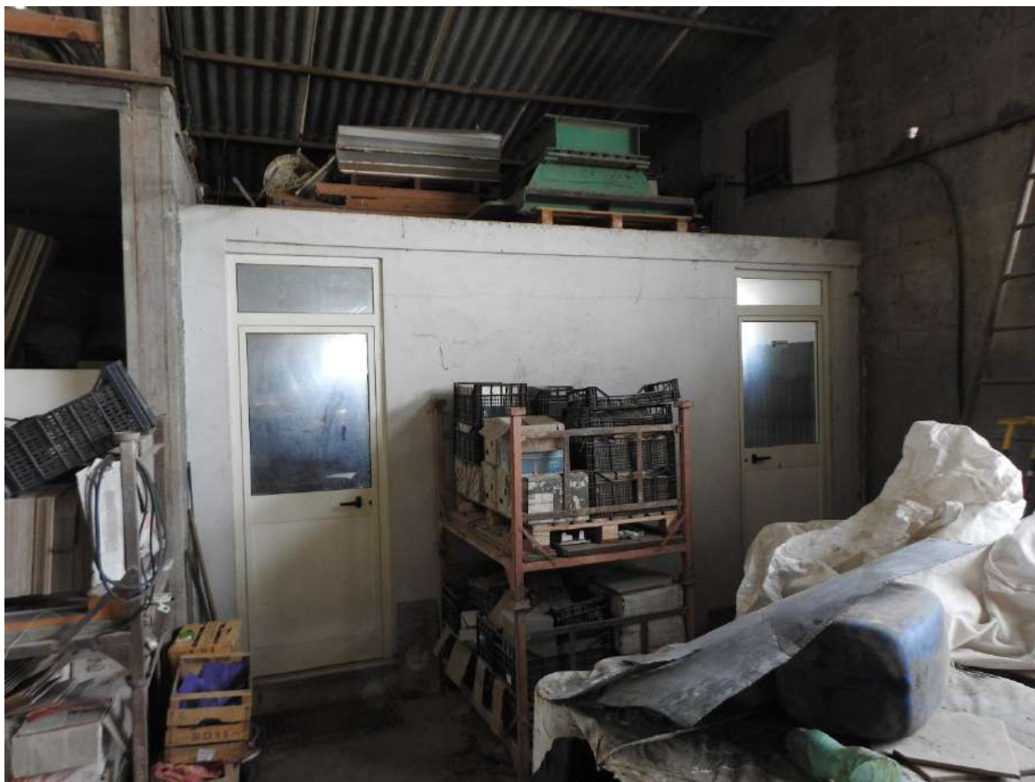
Figura 64 - Immobile 4 (capannone principale), blocco 4A. Visuale verso il blocco servizi (a sx la cucina, a dx spogliatoio con servizi igienici).
