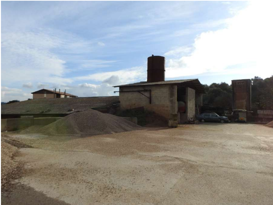
Figura 21 - Visuale del piazzale fronte strada vecchia.
