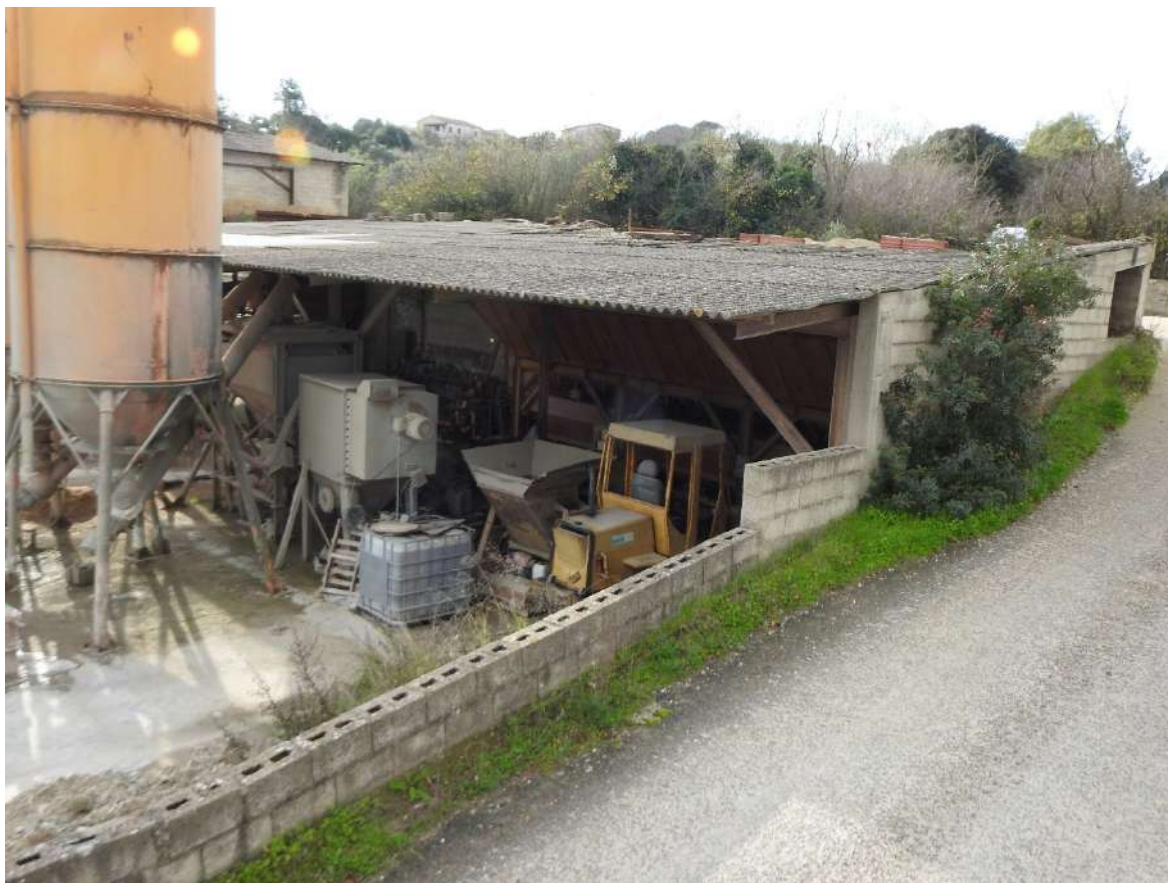
Figura 76 - Immobile 5 (tettoia operativa). Vista del prospetto principale e della copertura in eternit.
