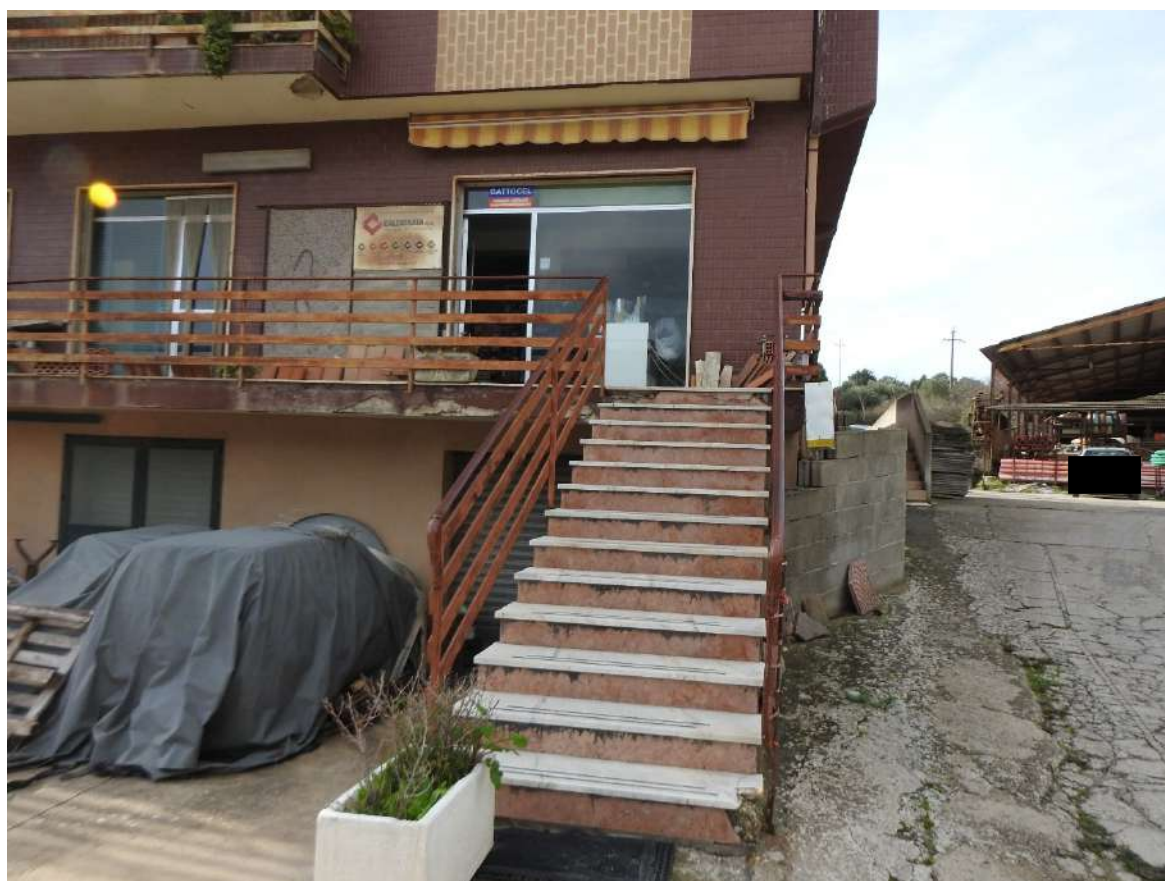
Figura 37 - Immobile 2 (negozio), particolare ingresso
