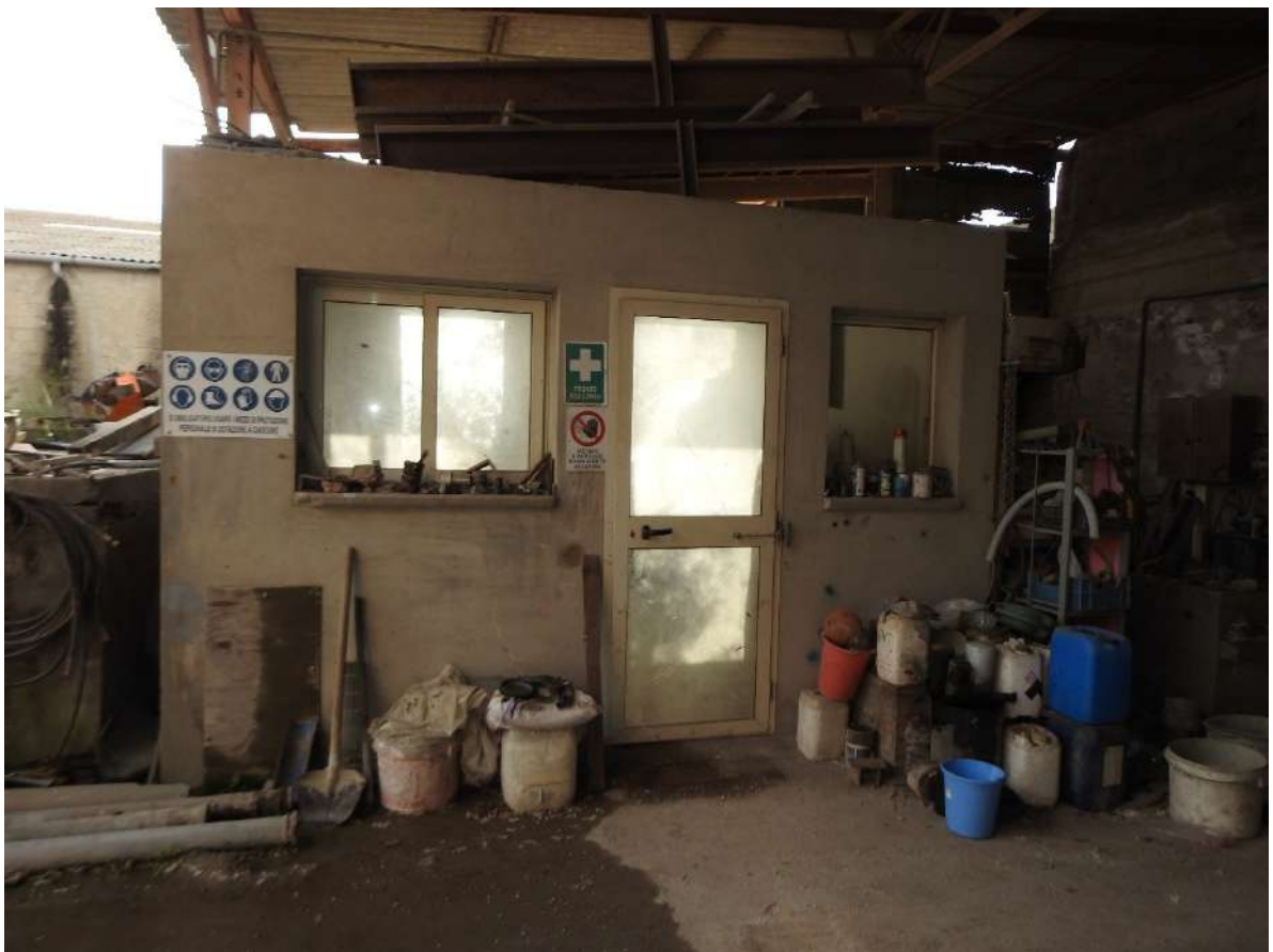
Figura 80 - Immobile 5 (tettoia operativa). Ufficio.
