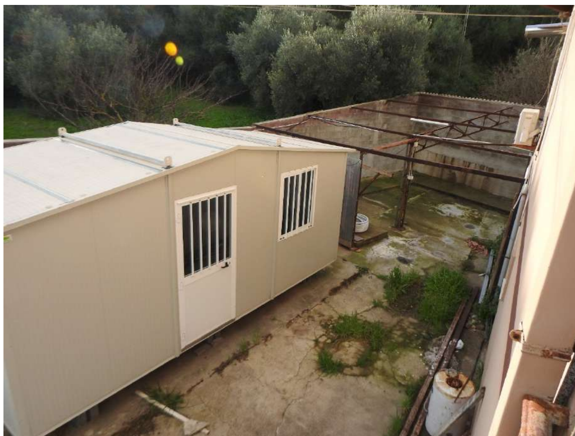
Figura 88 - Mappale 412 e relative installazioni. Visuale dalla palazzina verso deposito
