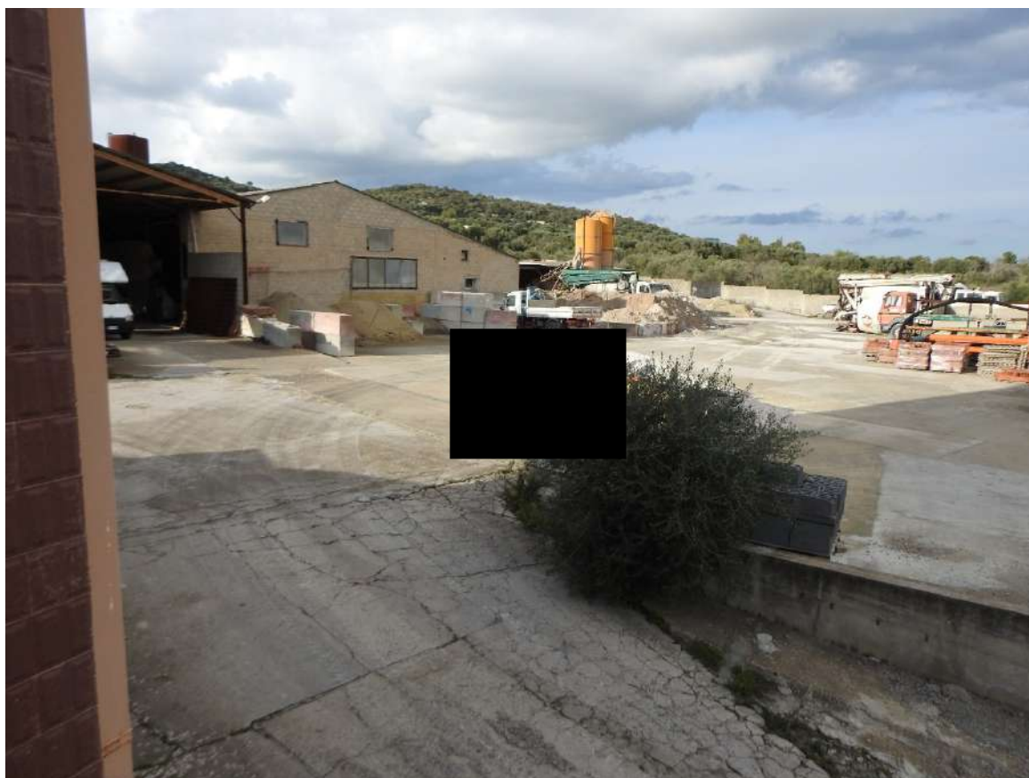
Figura 20 - Visuale generale del piazzale fronte SP44 dal bene di cui al punto 2 del pignoramento
