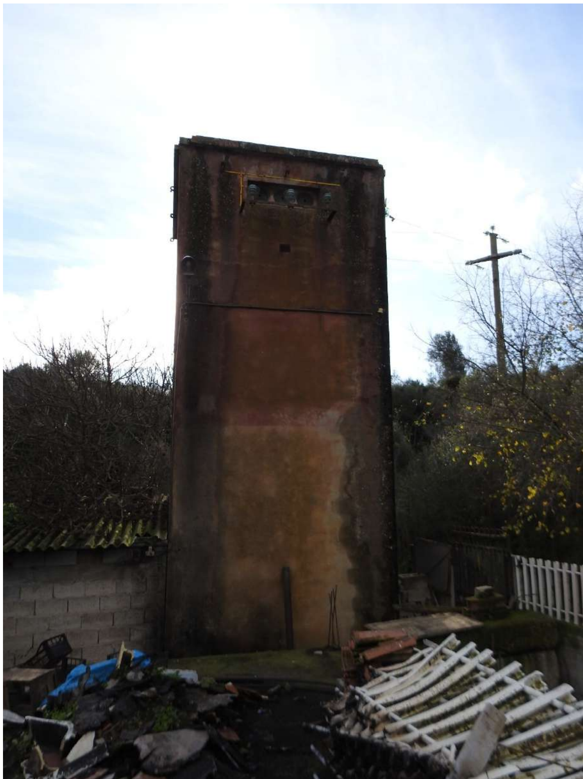
Figura 57 - Immobile 3 (cabina elettrica). Prospetto nord.
