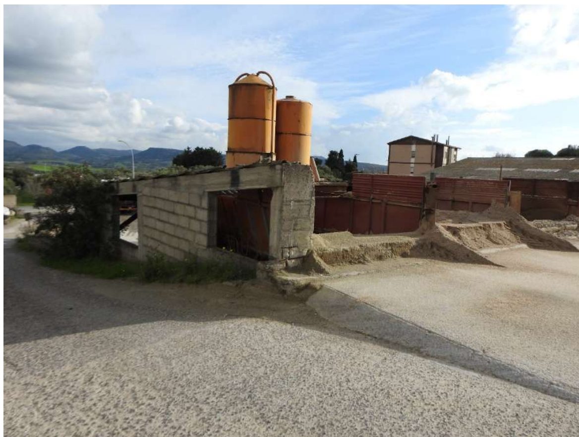
Figura 77 - Immobile 5 (tettoia operativa). Vista laterale/retro.
