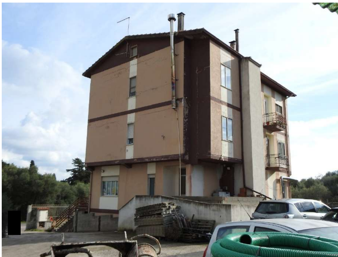
Figura 27 - Visuale della palazzina (facciata secondaria a ovest e parete laterale nord)
