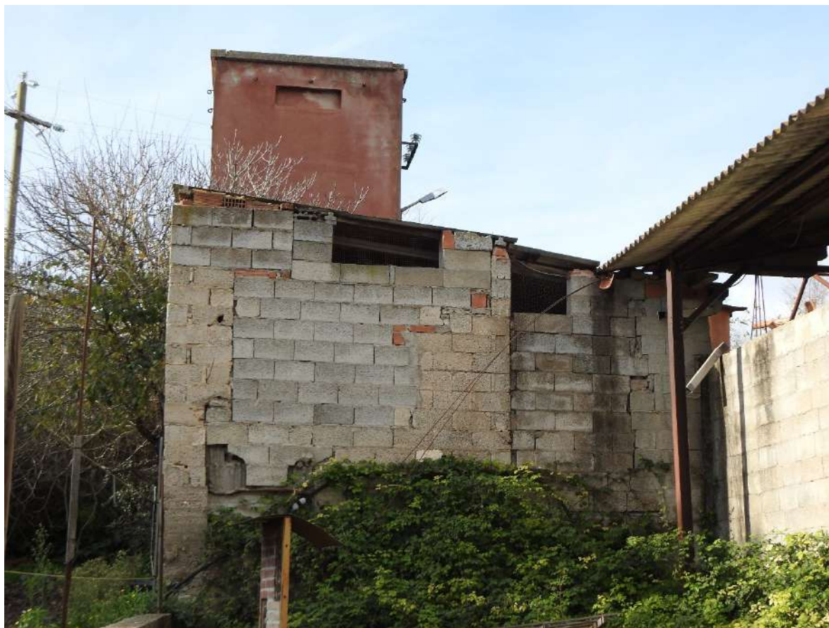
Figura 92 - Porcilaia. Visuale dal mappale 4365 verso la cabina elettrica. Particolare.
