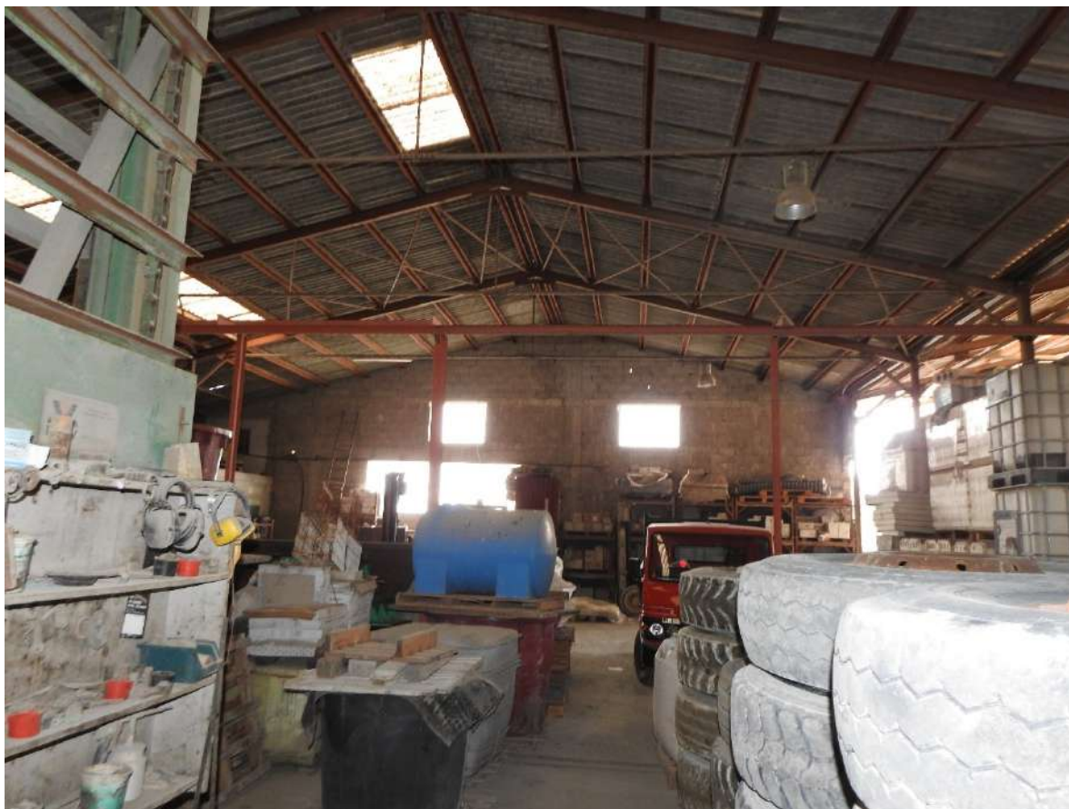
Figura 73 - Immobile 4 (capannone principale), blocco 4A. Visuale dal retro verso l'ingresso.
