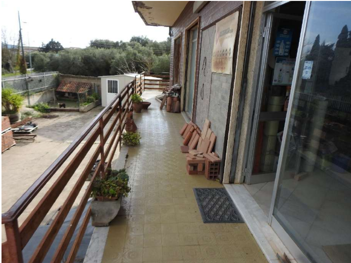
Figura 38 - Immobile 2 (negozi), balconata e ingresso principale
