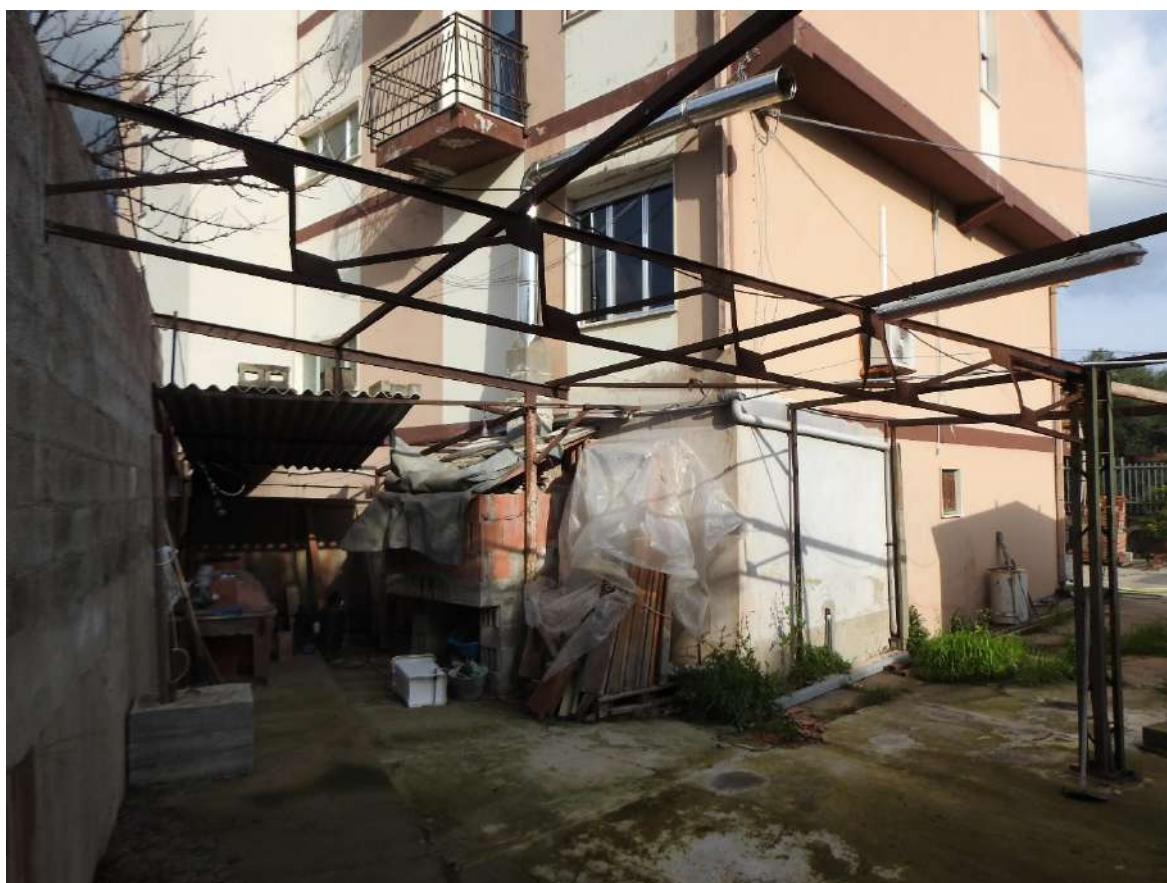
Figura 90 - Mappale 412 e relative installazioni. Particolare della struttura metallica del deposito.
