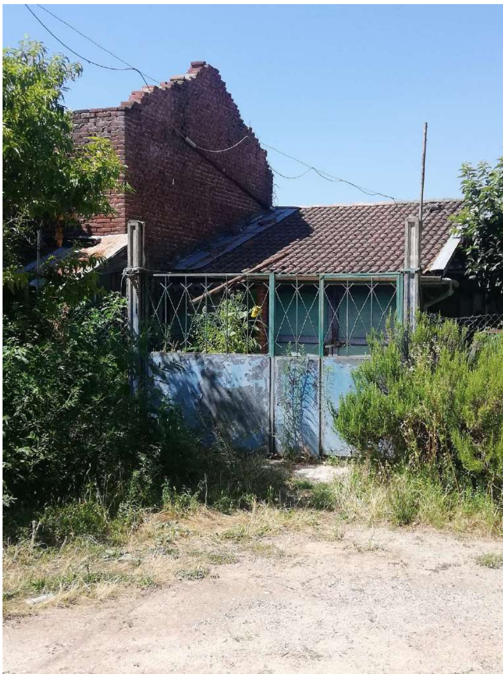
FOTO 13 – INGRESSO CARRAIO AUTORIMESSA
