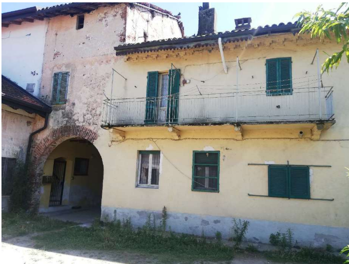
FOTO 3 – VISTA DA CORTILE INTERNO
