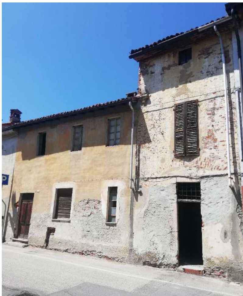
FOTO 1 – INGRESSO DA VIA DIONIGI RUVA
