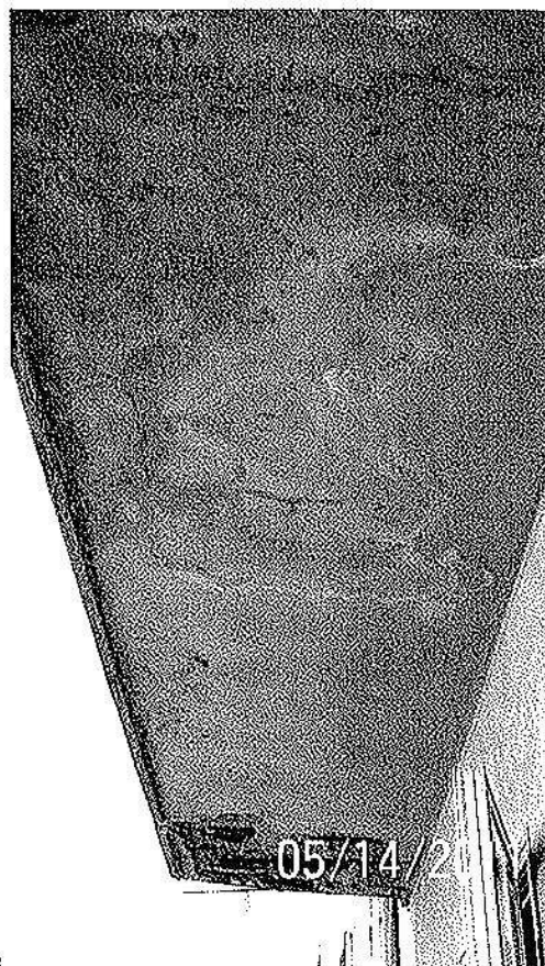
Degrado intradosso balcone
