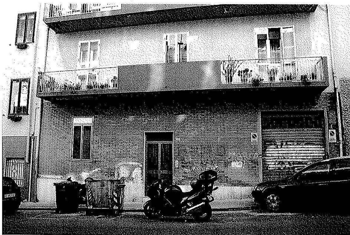
Facciata Via Redipuglia – p_terra e p_primo
