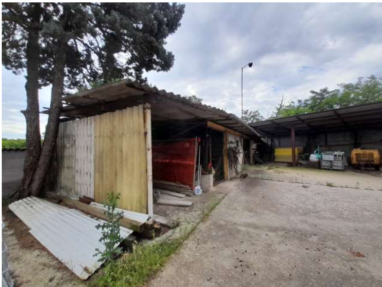
Foto n° 42 – MAGAZZINI E TETTOIA
