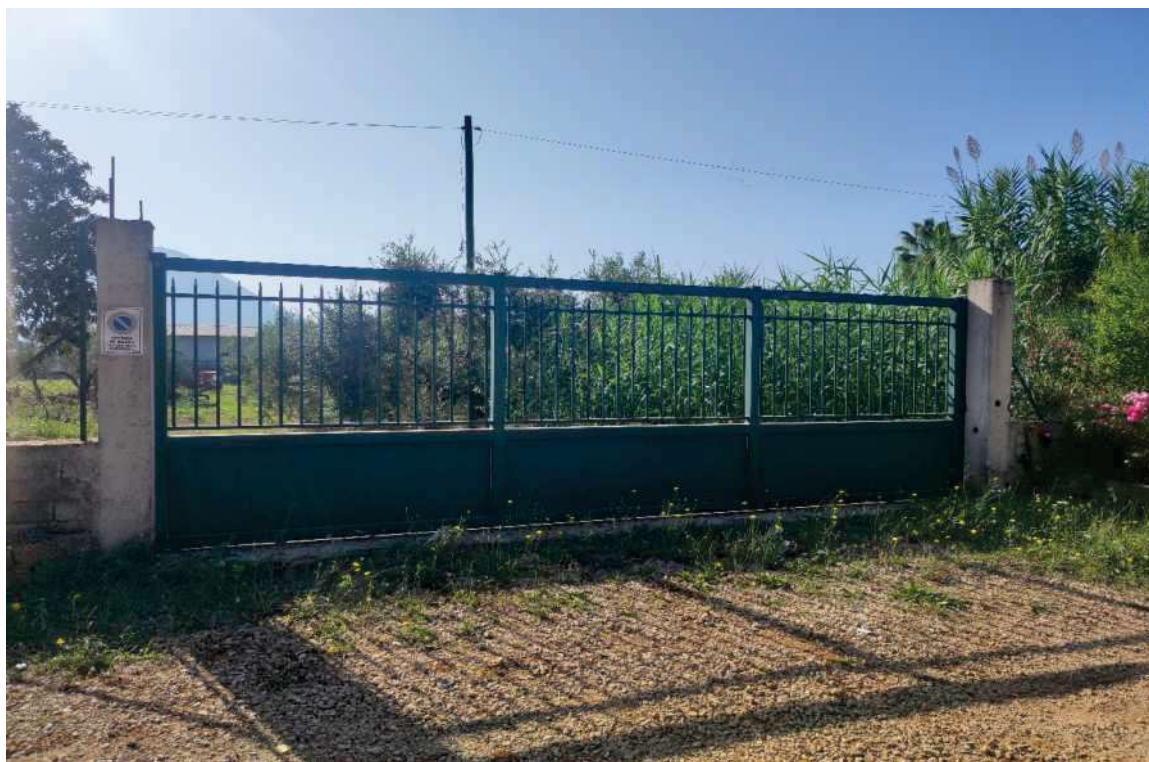
Foto n. 11 – (LOTTO 2) terreno delimitato da cancello carrabile fronte strada via Madonna dei Martiri
