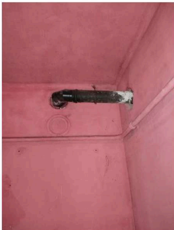
Collegamento stufa a pellet a canna fumaria
