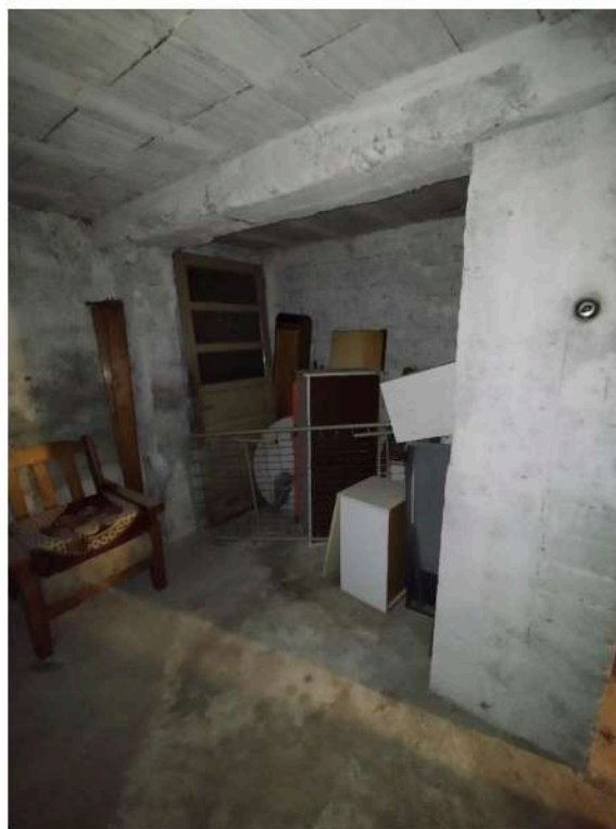
vista dall'interno verso appendice a sud
