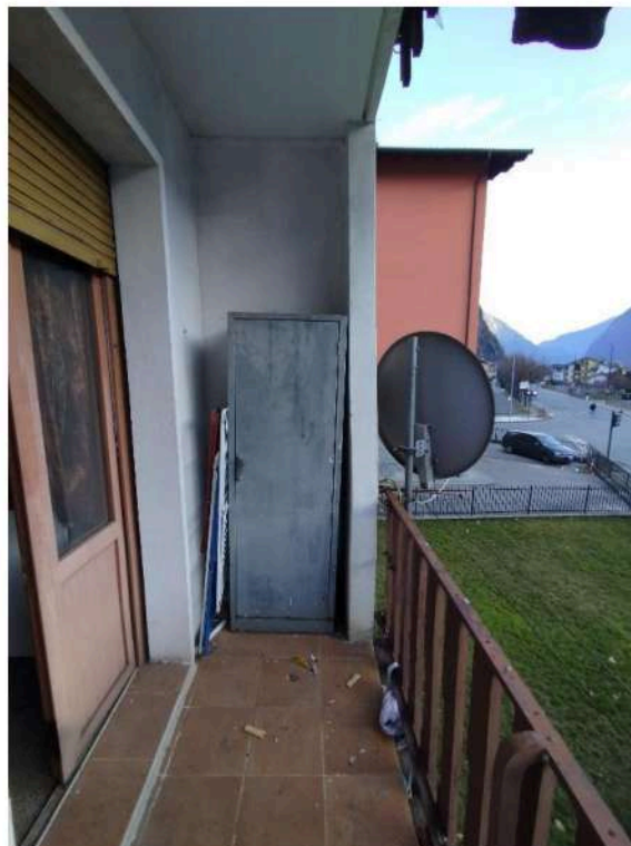
Terrazzo a sud vista est
