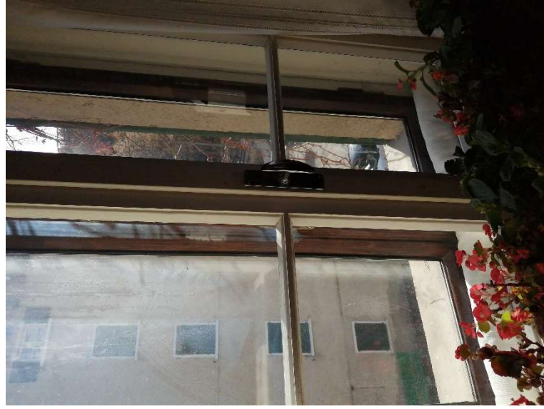
particolare serramenti in legno 1
