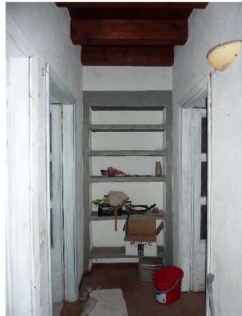
Disimpegno piano primo
