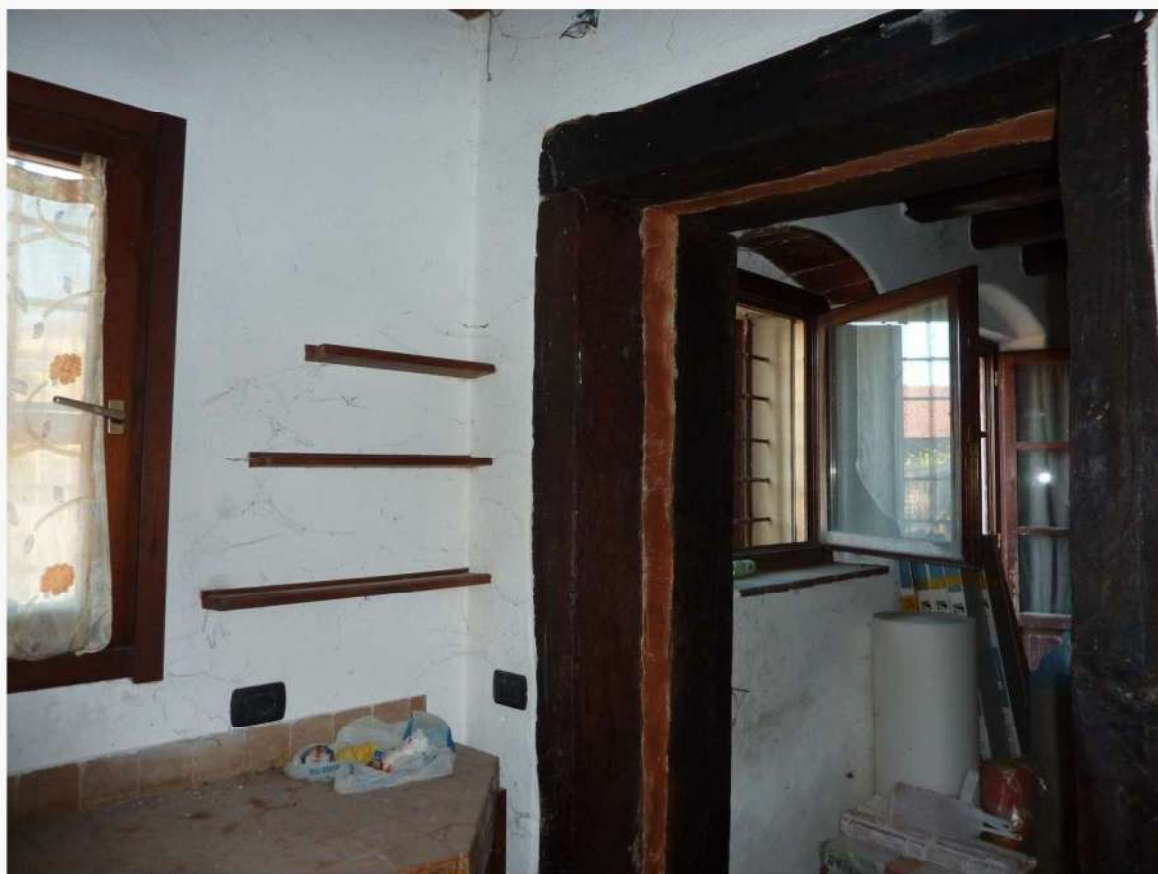
FOTO 6 _ VISTA INTERNA – CUCINA – PIANO TERRA
