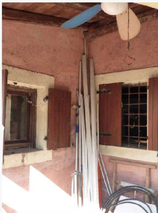
FOTO 12 _ DETTAGLIO PORTICATO SULLA PORZIONE AD OVEST DEL FABBRICATO
