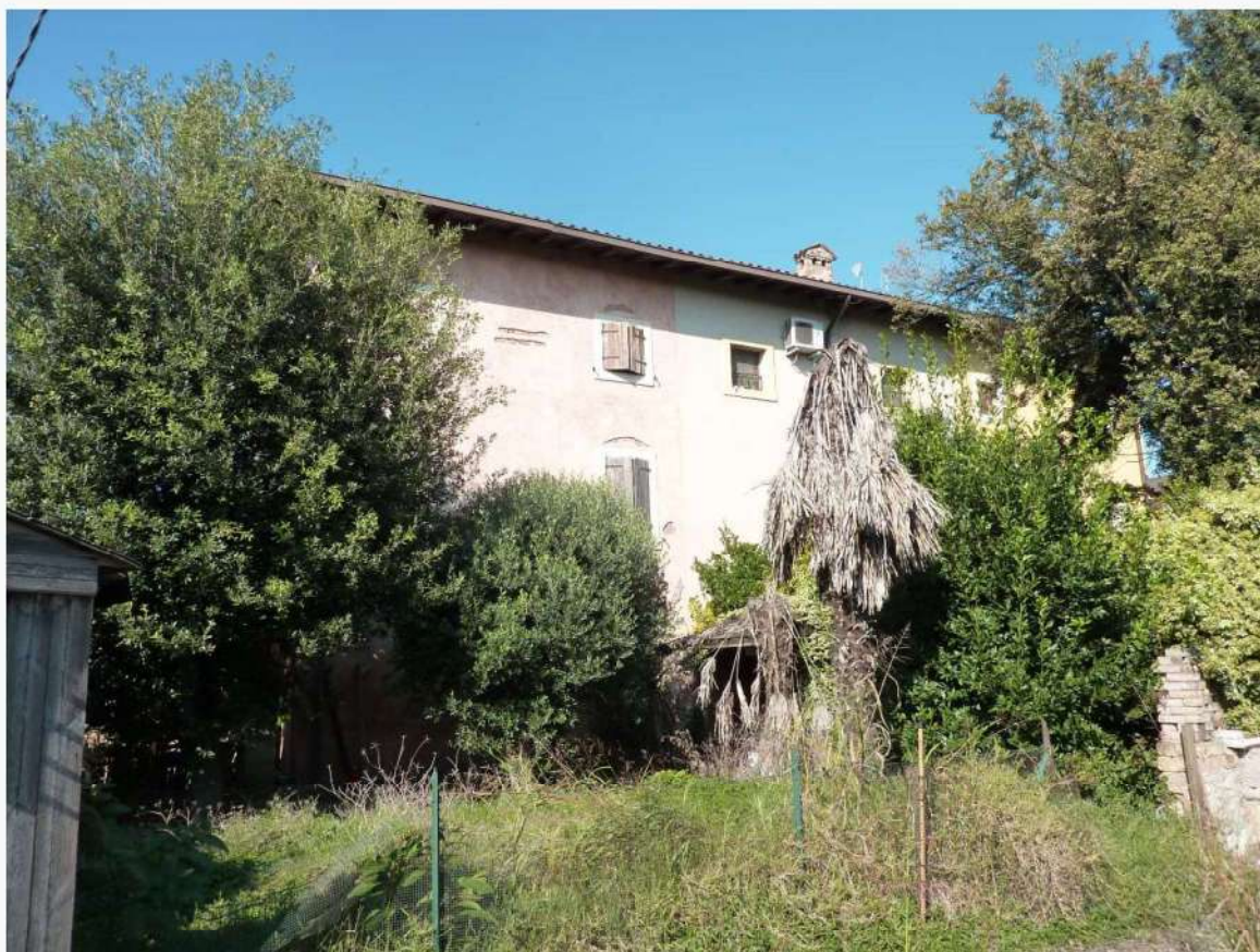
FOTO 13 _ VISTA DEL RETRO DEL FABBRICATO E DELL' AREA ESTERNA PERTINENZIALE ESCLUSIVA DELL'UNITA' IMMOBILIARE – PROSPETTO SUD
