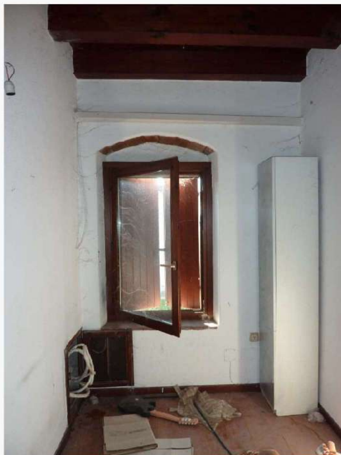
FOTO 11 _ VISTA INTERNA – RIPOSTIGLIO – PIANO PRIMO
