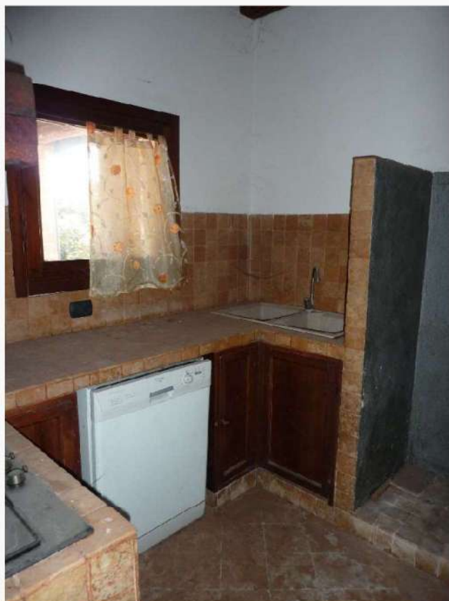
FOTO 5 _ VISTA INTERNA – CUCINA – PIANO TERRA
