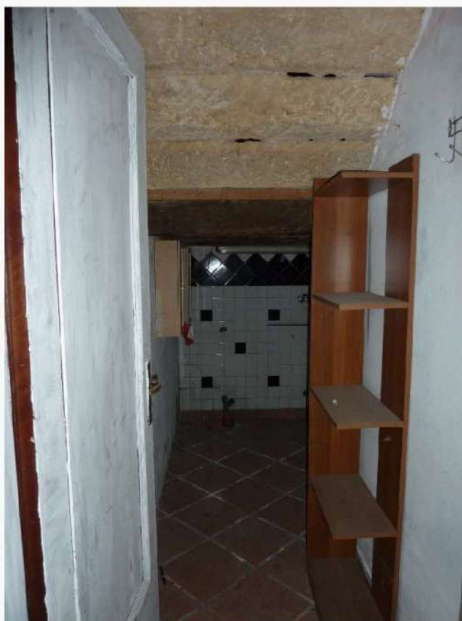
FOTO 8 _ VISTA INTERNA –RIPOSTIGLIO SOTTOSCALA – PIANO TERRA
