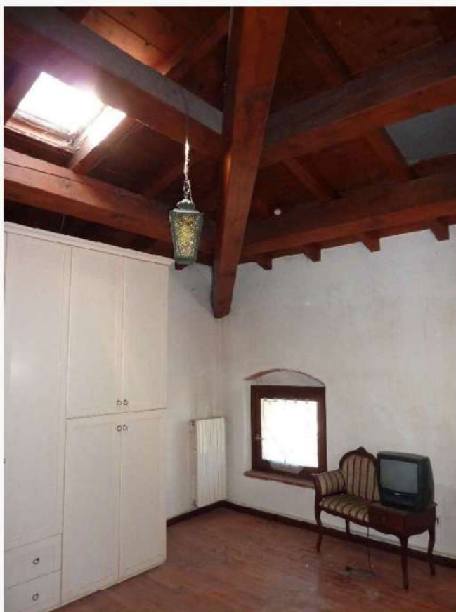
FOTO 20 _ VISTA INTERNA – CAMERA – PIANO SECONDO
