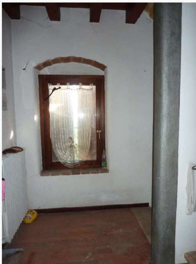
FOTO 13 _ VISTA INTERNA – PIANEROTTOLO VANO SCALE – PIANO PRIMO
