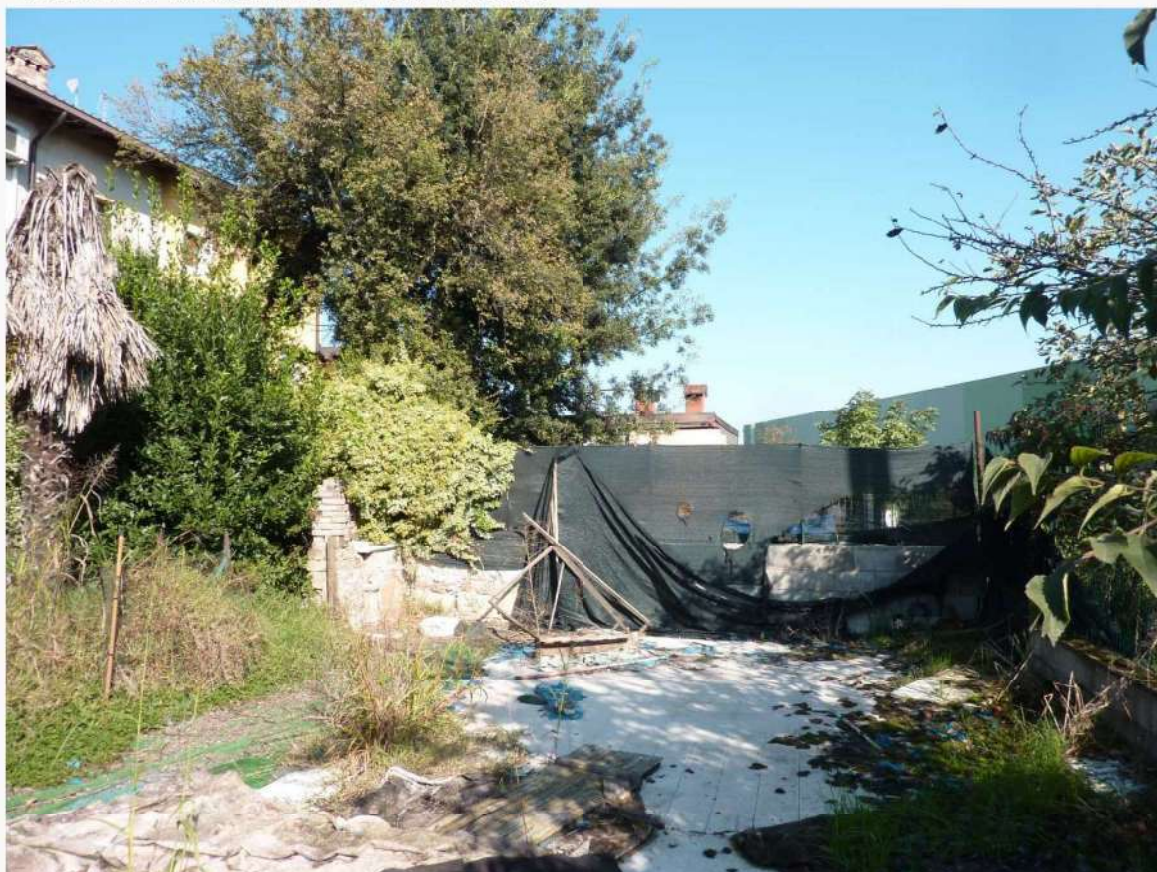
FOTO 14 _ VISTA DEL RETRO DEL FABBRICATO E DELL' AREA ESTERNA PERTINENZIALE ESCLUSIVA DELL'UNITA' IMMOBILIARE – PROSPETTO SUD
