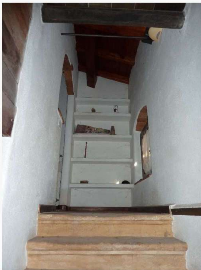
FOTO 16 _ VISTA INTERNA – VANO SCALE DI COLLEGAMENTO TRA PIANO PRIMO E SECONDO
