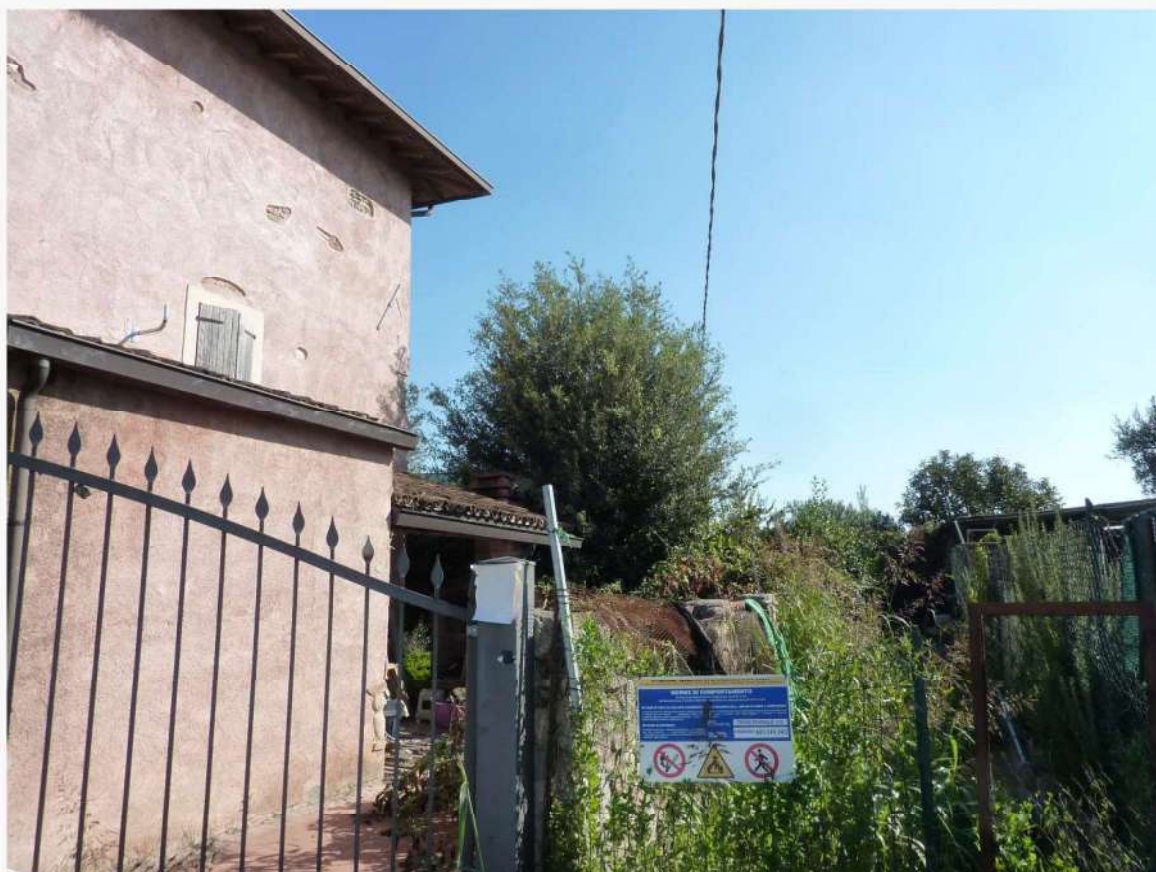
FOTO 8 _ VISTA DEL CANCELLO DI INGRESSO E DEL VIALETTO LATERALE COMUNE
