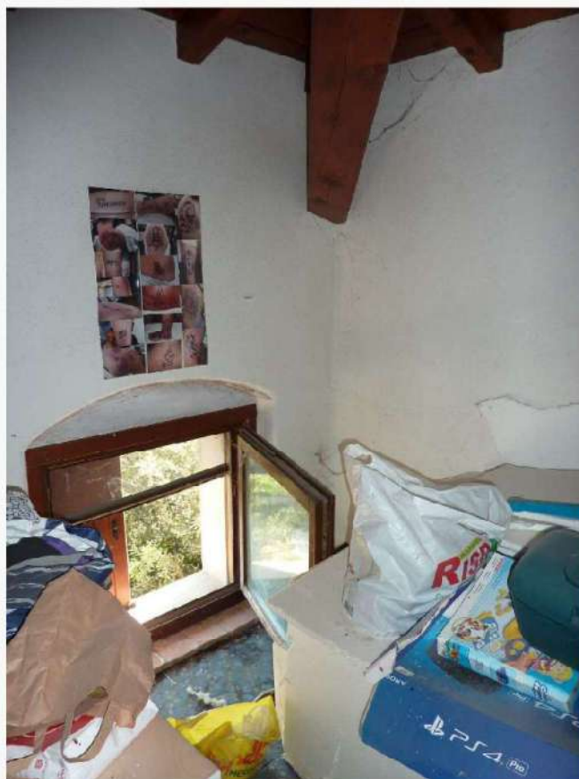
FOTO 23 _ VISTA INTERNA – RIPOSTIGLIO – PIANO SECONDO
