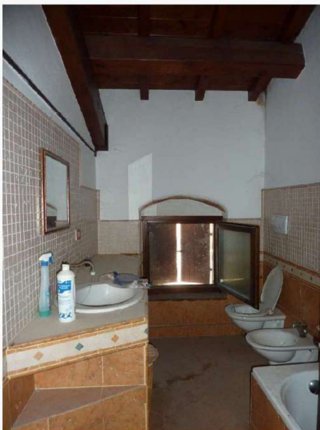
FOTO 18 _ VISTA INTERNA – BAGNO – PIANO SECONDO
