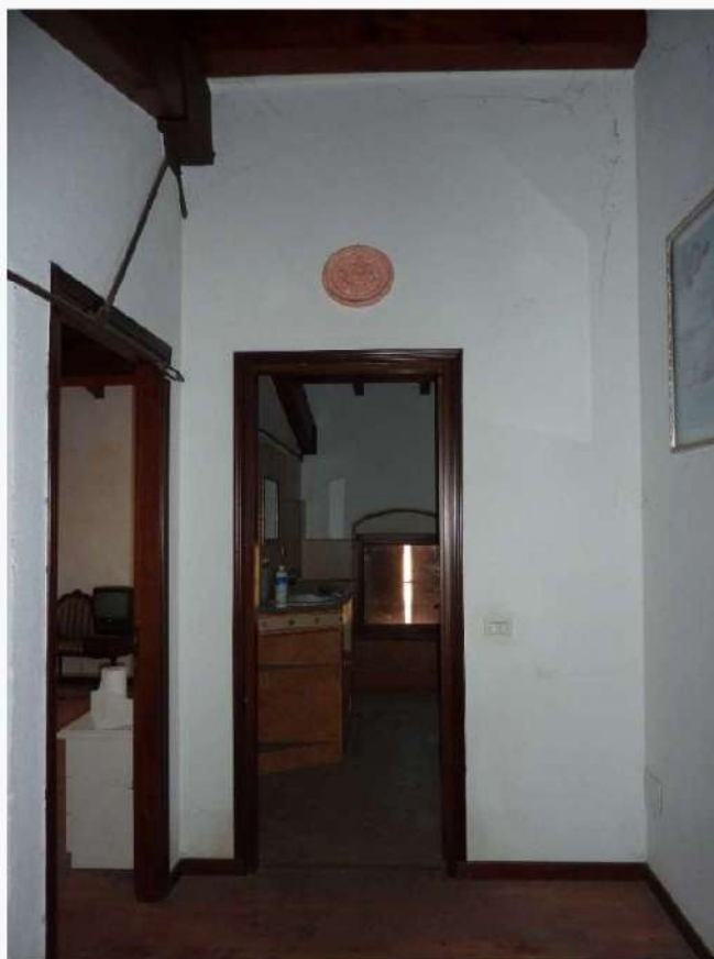
FOTO 17 _ VISTA INTERNA – DISIMPEGNO – PIANO SECONDO
