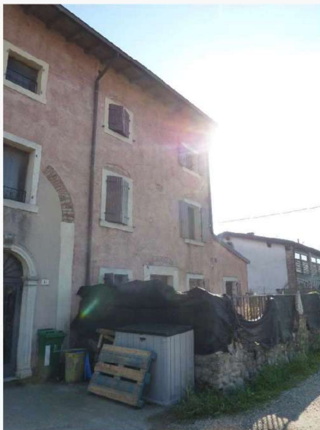
FOTO 7 _ DETTAGLIO DEL PROSPETTO NORD DEL COMPLESSO IMMOBILIARE DALLA STRADA DI ACCESSO PRIVATA SUB 21
