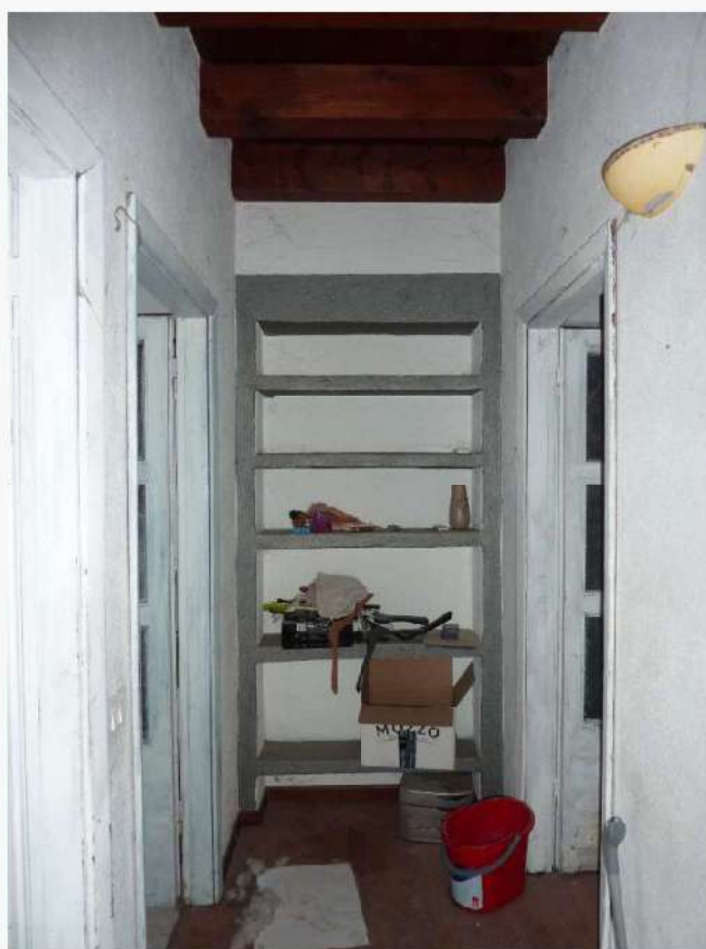
FOTO 12 _ VISTA INTERNA – DISIMPEGNO – PIANO PRIMO
