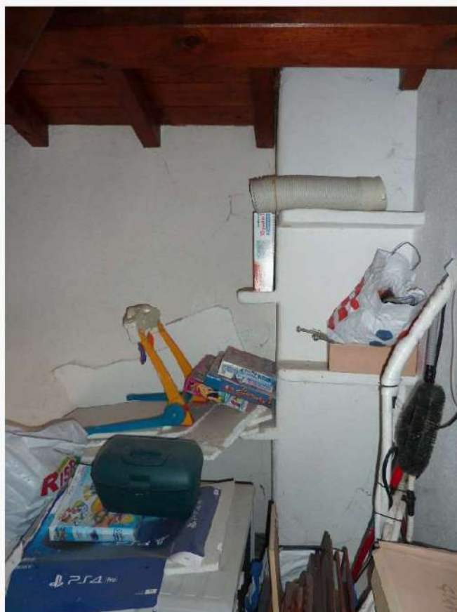
FOTO 24 _ VISTA INTERNA – RIPOSTIGLIO – PIANO SECONDO
