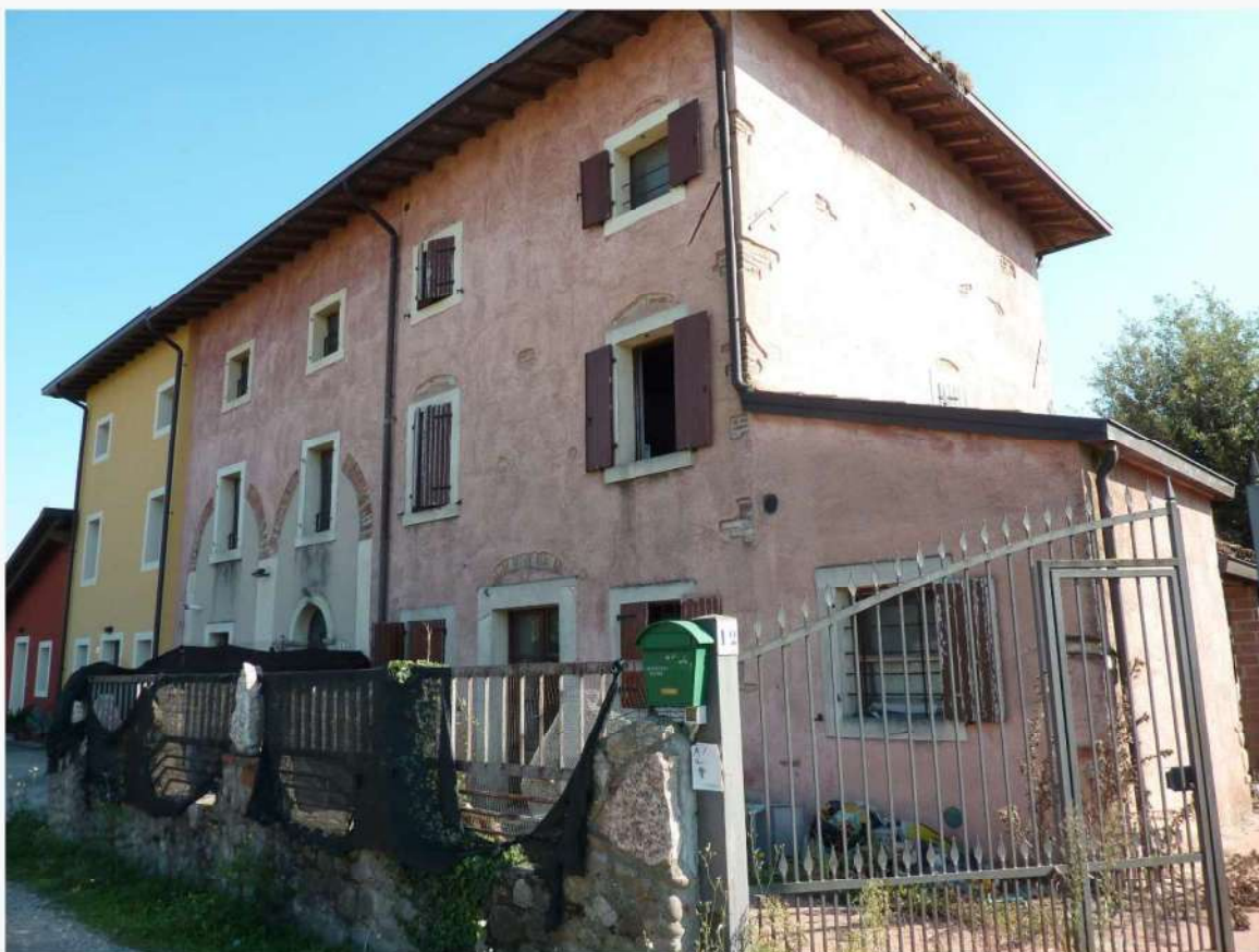
FOTO 6 _ DETTAGLIO DEL COMPLESSO IMMOBILIARE DALLA STRADA DI ACCESSO PRIVATA SUB 21- PROSPETTI NORD ED OVEST
