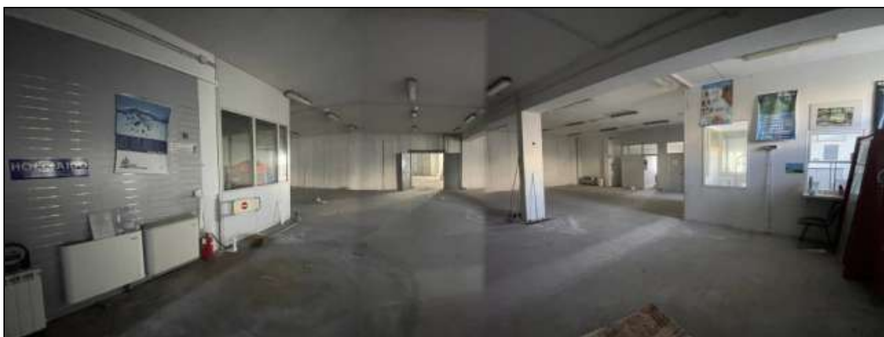
Foto "42" – PIANO TERRA – Magazzino –Zona nord-ovest
