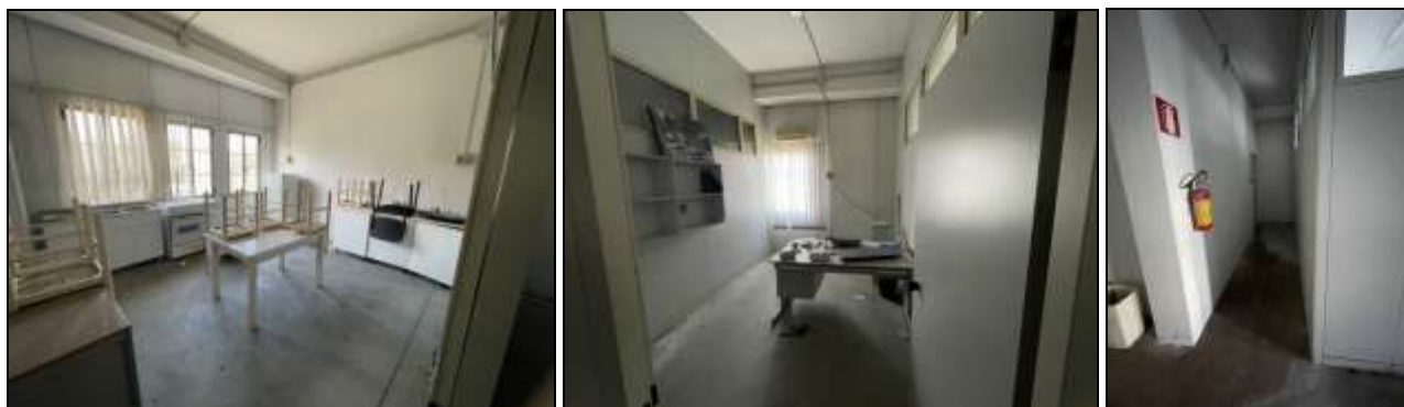
Foto "47-48-49" – PIANO TERRA – Locali e Servizi con accesso dal Magazzino – Zona nord-ovest
