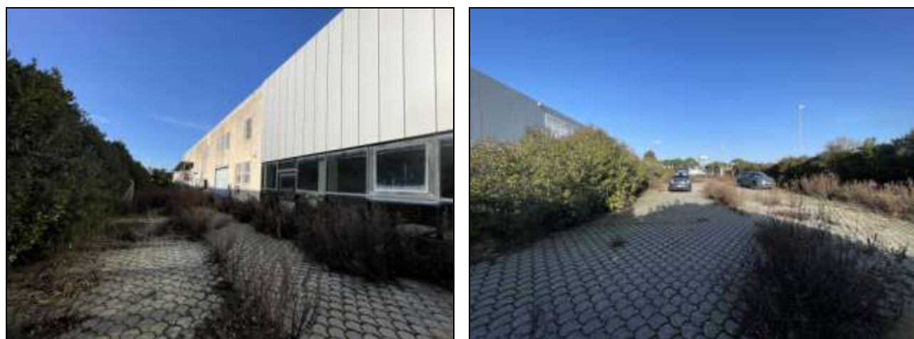
Foto "14-15" – Vista dalla corte esclusiva – zona sud / est
