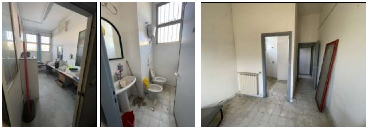
Foto "44-45-46" – PIANO TERRA – Locali e Servizi con accesso dal Magazzino – Zona nord-ovest
