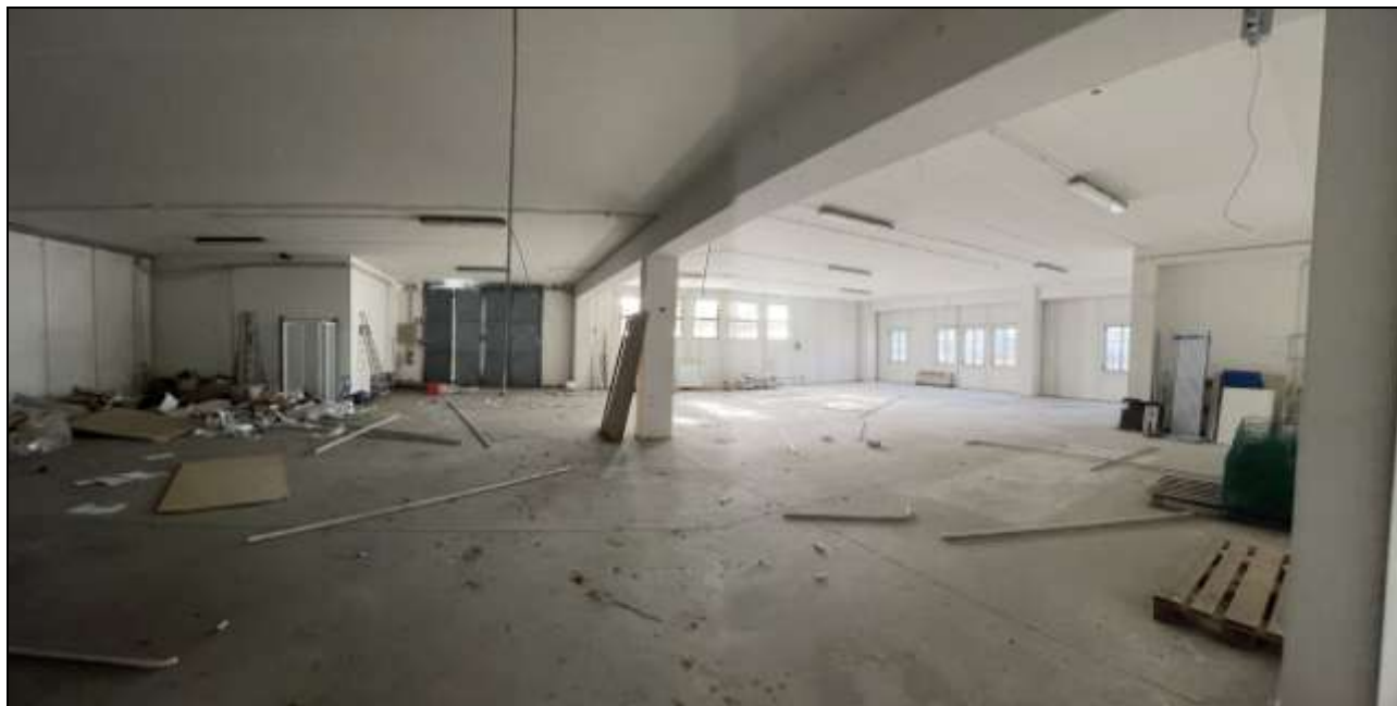
Foto "50" – PIANO TERRA – Magazzino – Zona sud-ovest
