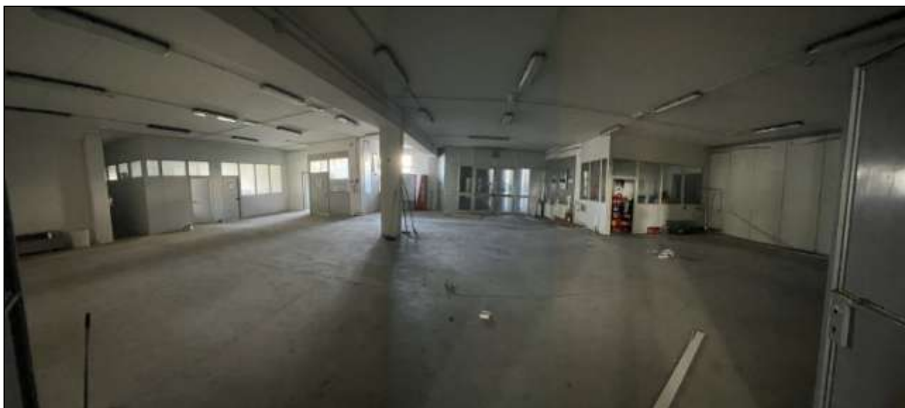
Foto "43" – PIANO TERRA – Magazzino – Zona nord-ovest
