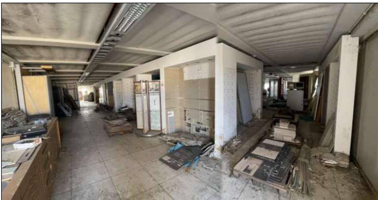
Foto "63" – PIANO PRIMO – Magazzino – Zona ovest
