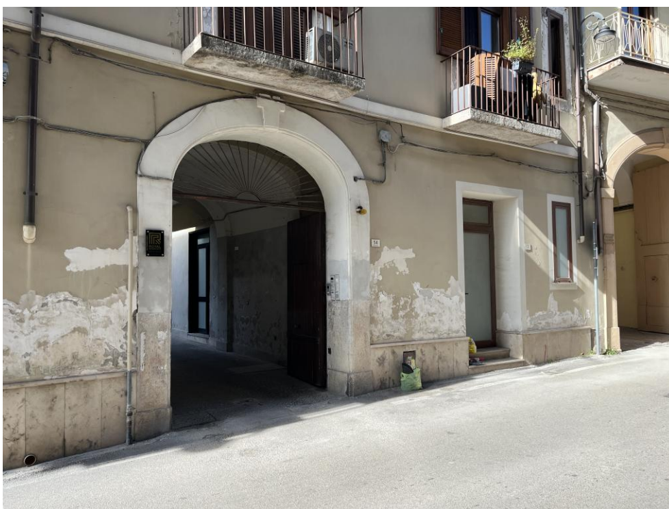
PORTONE DI INGRESSO DEL FABBRICATO
