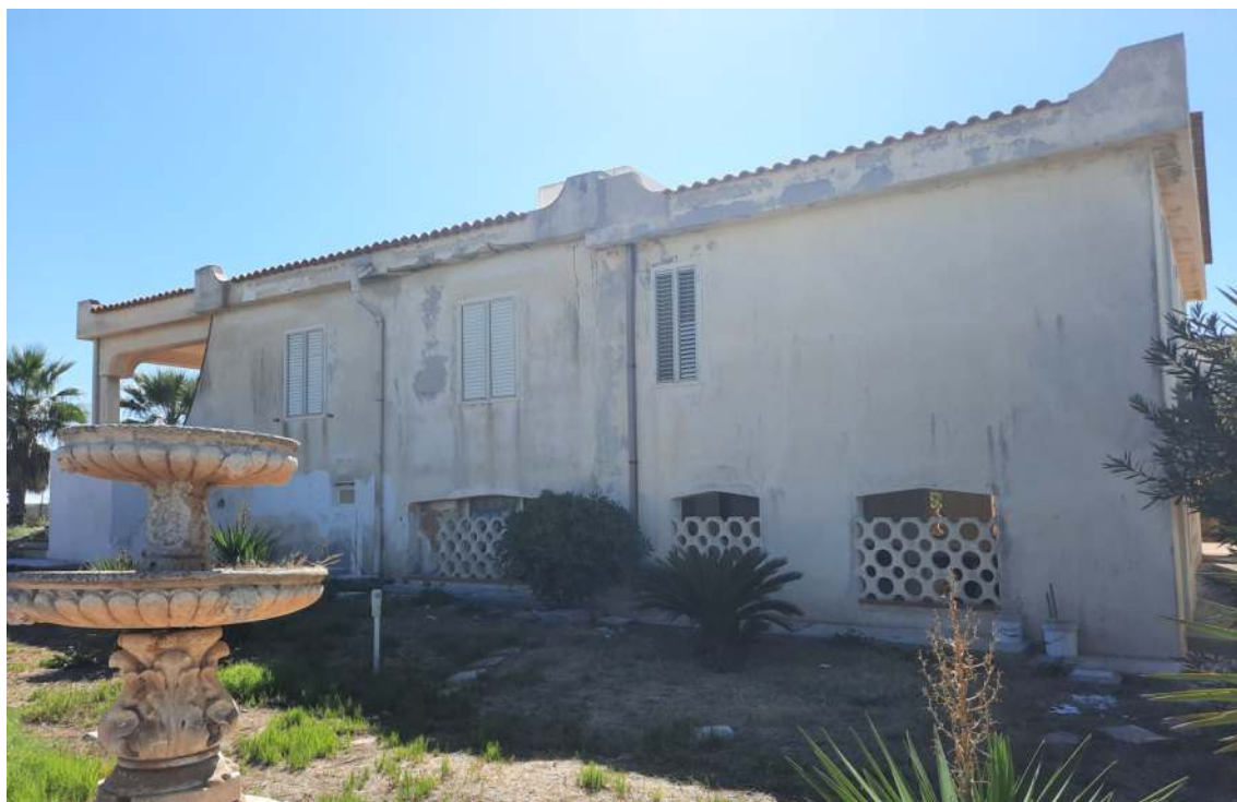
2_Prospetto Nord della villa
