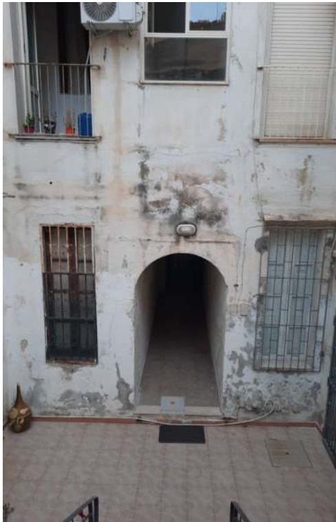
3 _la corte interna all'edificio che ospita l'appartamento pignorato
