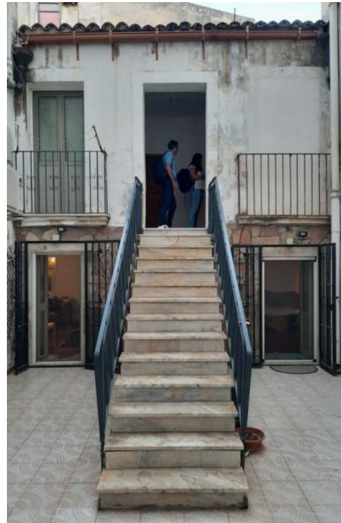
4 _la scala all'interno della corte che conduce all'appartamento pignorato
