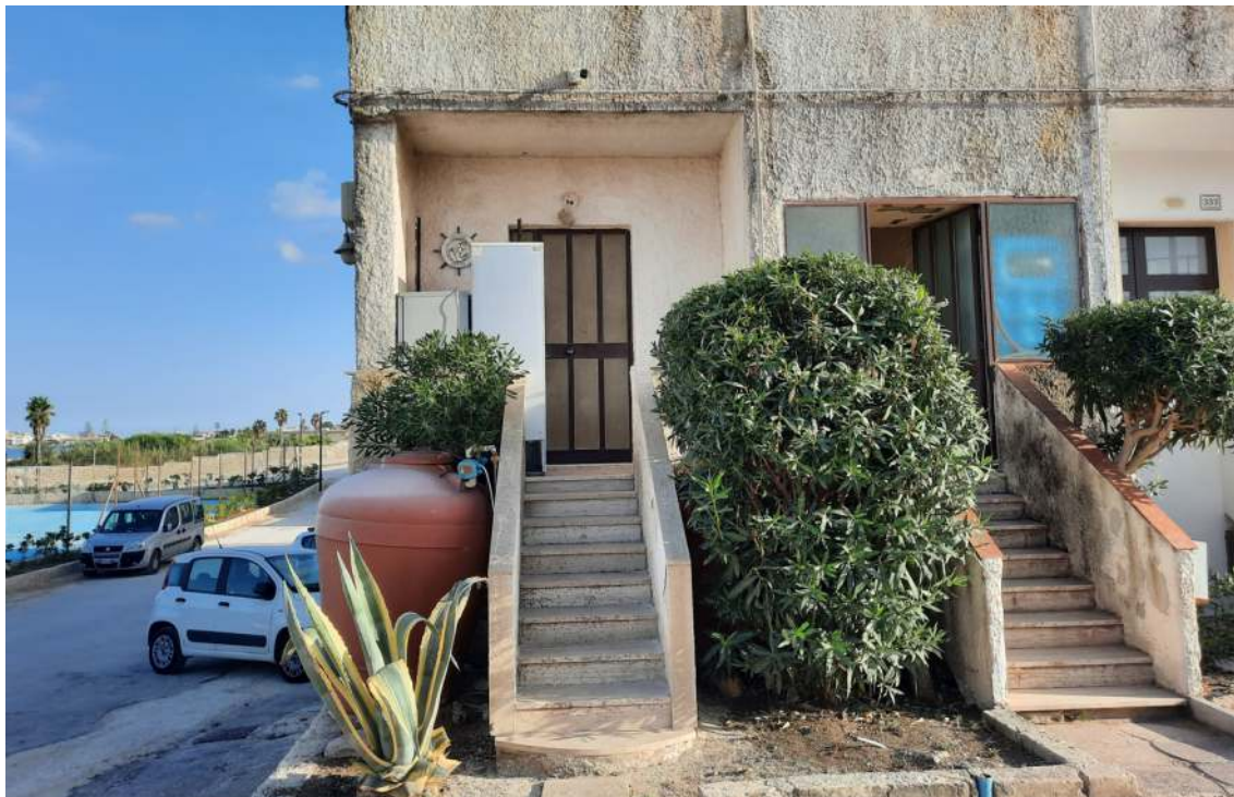
3_ la scala che conduce alla porte d'accesso all'appartamento pignorato
