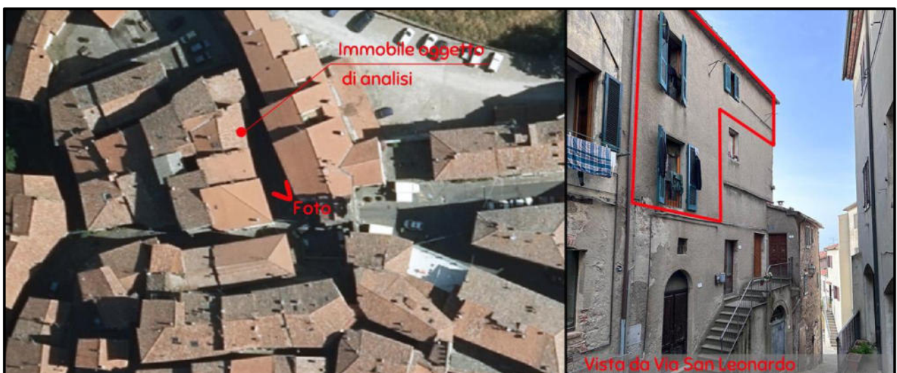
Accesso all'immobile: ortofoto e vista complessiva del fabbricato da Sud, dalla via San Leonardo
