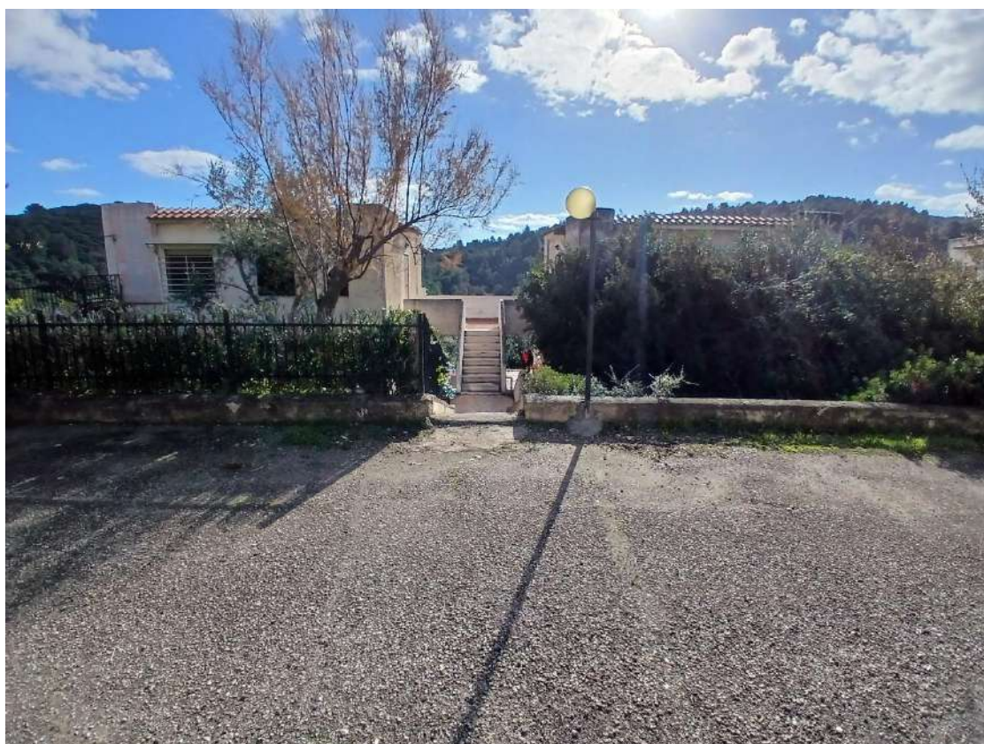
Accesso all’abitazione da strada interna al Residence
