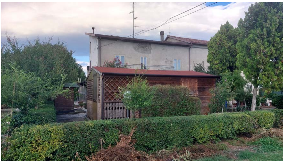
30) Vista esterna, con evidenza dei fabbricati in legno da rimuovere.
