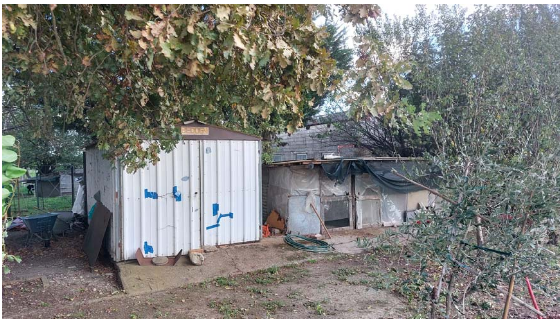
31) Vista esterna, con evidenza dei fabbricati da rimuovere.
