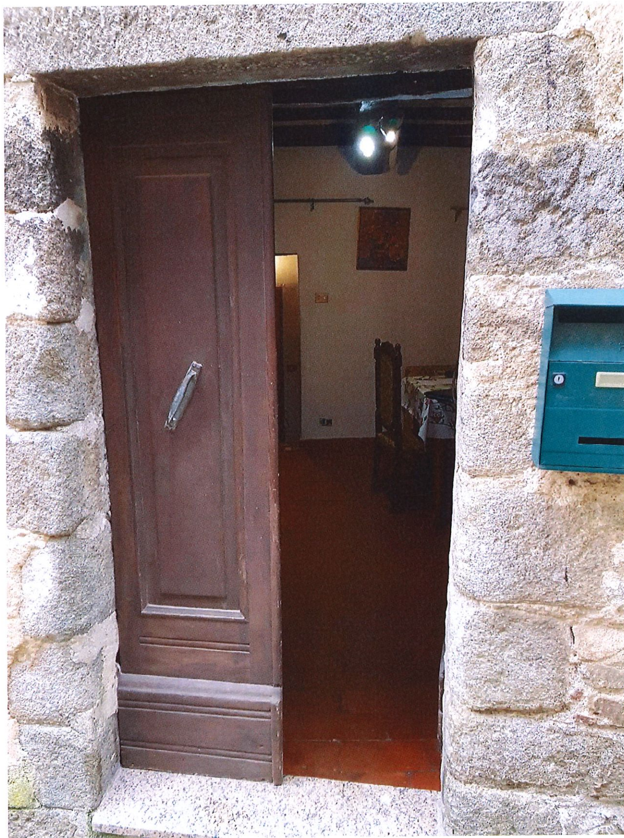
PORTONE DI ACCESSO ALLA CUCINA
