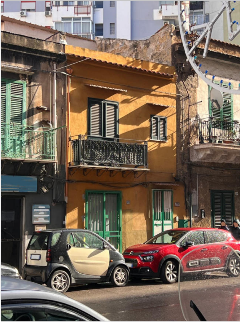
vista su via Oreto
