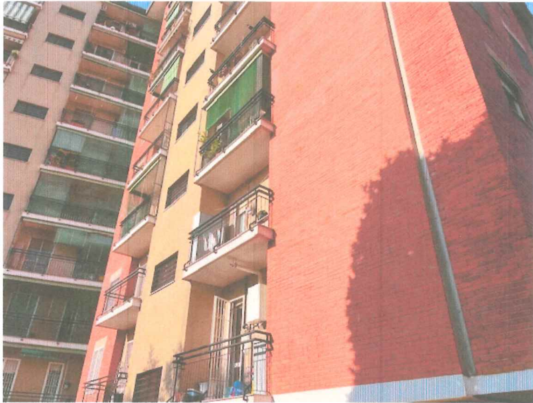
Esterno dell'immobile verso cortile
