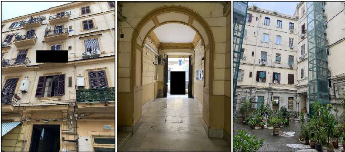
Figura 3. Prospetto del fabbricato da via Cairoli (sinistra) e androne/cortile interno (destra).
