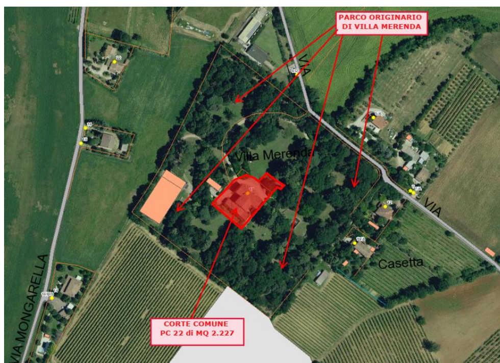
AEROFOTO - PARTICOLARE DELLA CORTE COMUNE (particella 22 di mq 2.227) RISPETTO ALL'ENTITA' DELL'INTERO ED ORIGINARIO PARCO DELLA VILLA
