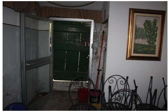
ACCESSO DALL'ESTERNO, COMUNICANTE CON IL VANO SCALA, ATTO A CONSENTIRE IL PASSAGGIO PER ACCEDERE AL PIANO SECONDO (sottotetto)
