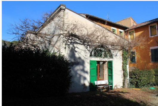
PARTICOLARE PROSPETTO EST; PORTA DELLA ZONA PRANZO
