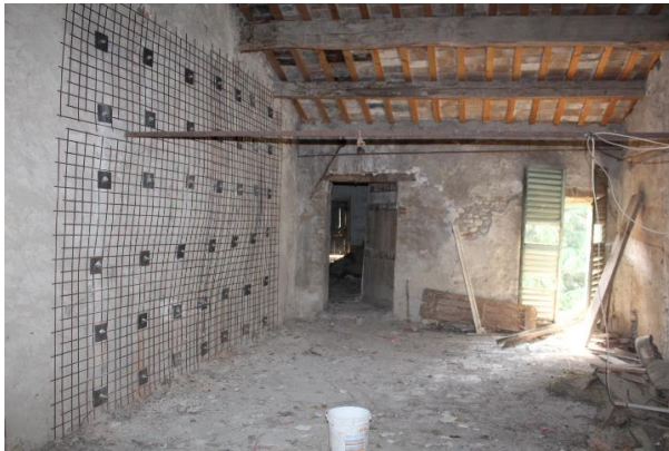
PARTICOLARE DEI RINFORZI STRUTTURALI ESEGUITI
