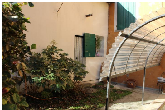
PARTICOLARE DELL'ACCESSO ALLA CENTRALE TERMICA, AUTONOMO RISPETTO ALL'APPARTAMENTO E DA CORTE RECINTATA A BENEFICIO ESCLUSIVO DI ALTRI SOGGETTI
