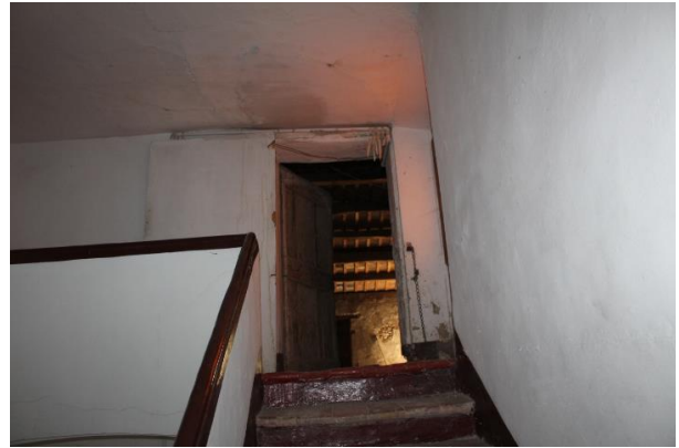
ARRIVO DELLA SCALA AL SECONDO PIANO (sottotetto)
