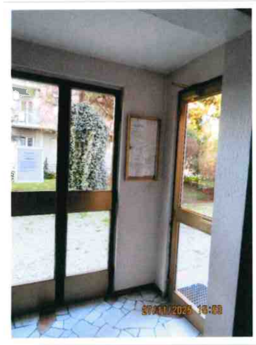
Particolare dell'ingresso condominiale.
