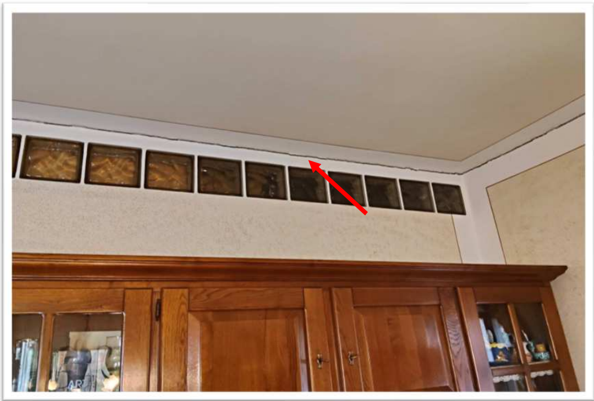
Foto n. 8 cucina particolare lesione - foto del 04/06/2026
