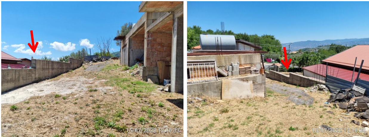
Foto 4.2_2 e 3 – Muro di sostegno in c.a
