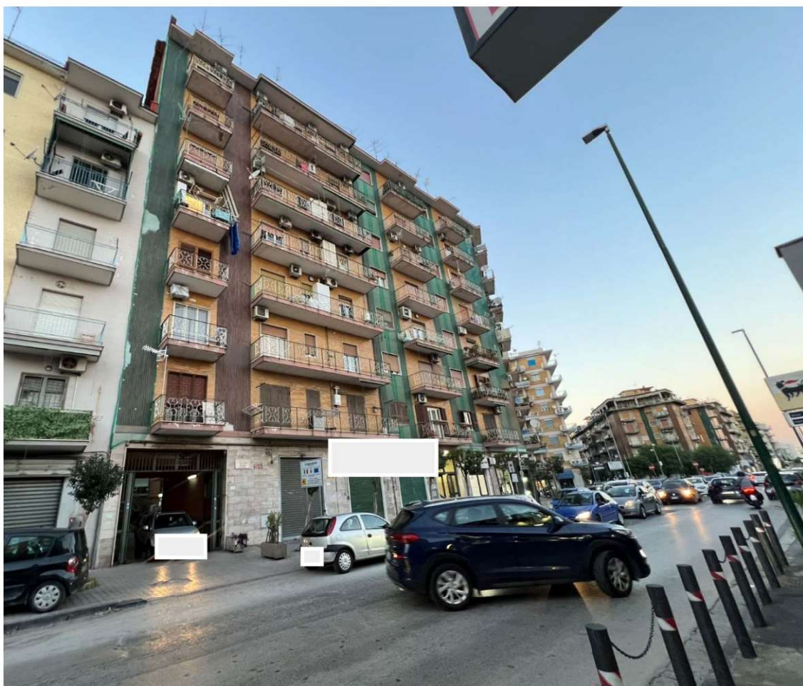
Dettaglio della porzione del fabbricato, servito dalla scala A, che prospetta su via Taverna Rossa
