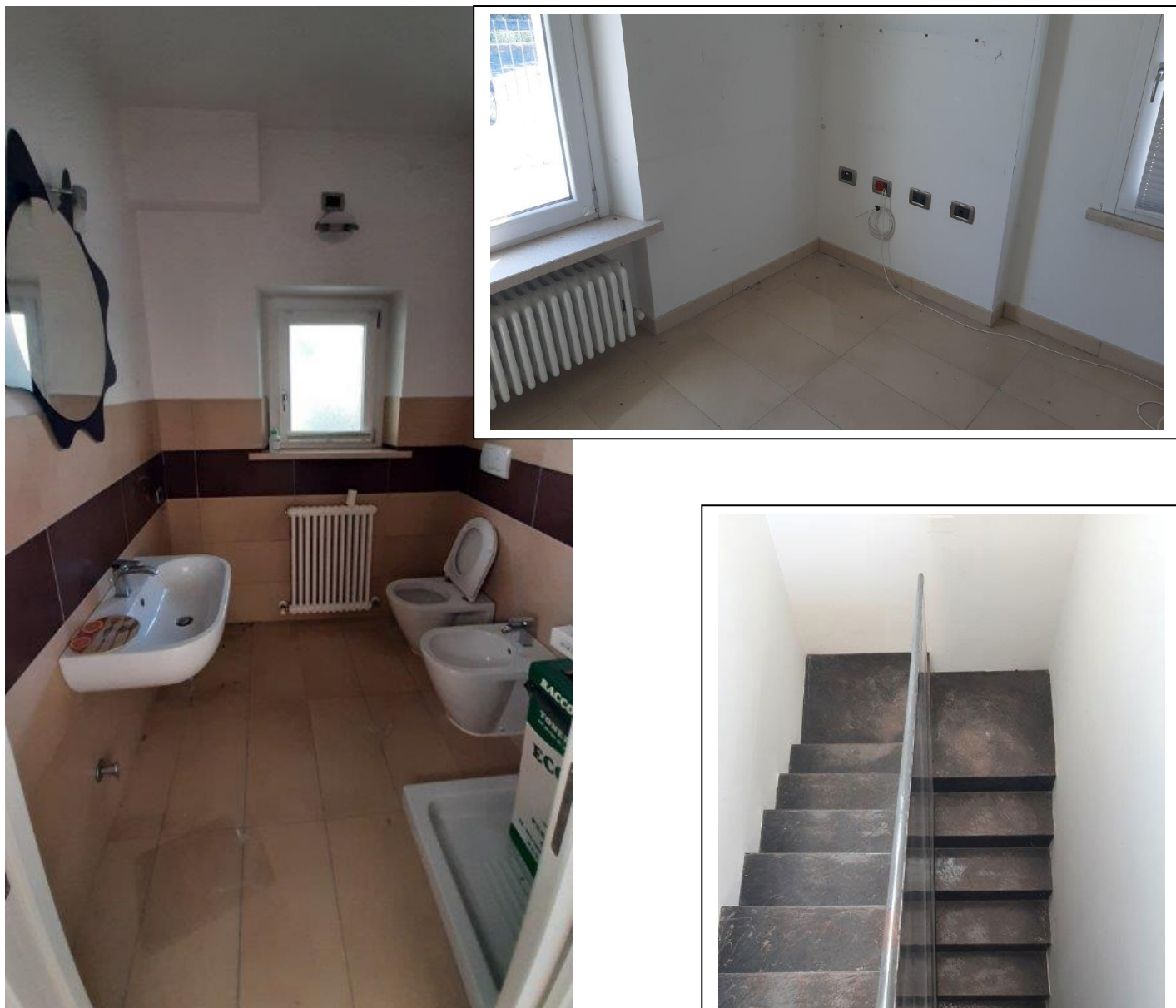
Foto 48 – Vista del bagno all'interno dell'unità al PT di cui sopra.
