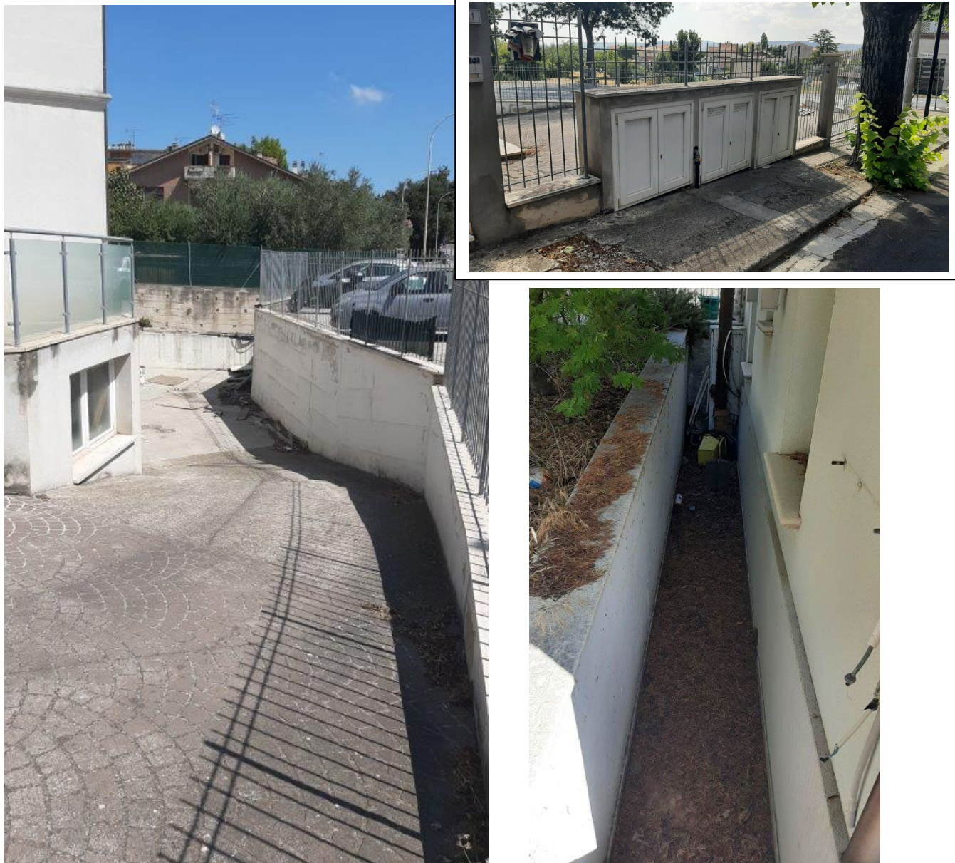
Foto 16, 17 e 18 – Vista della rampa che conduce allo scoperto e alla unità al piano interrato, del vano contatore acqua, luce e gas delle unità costituenti il fabbricato e del cavedio che separa l'edificio dallo scoperto al PT in corrispondenza del prospetto su via A. Gramsci.
