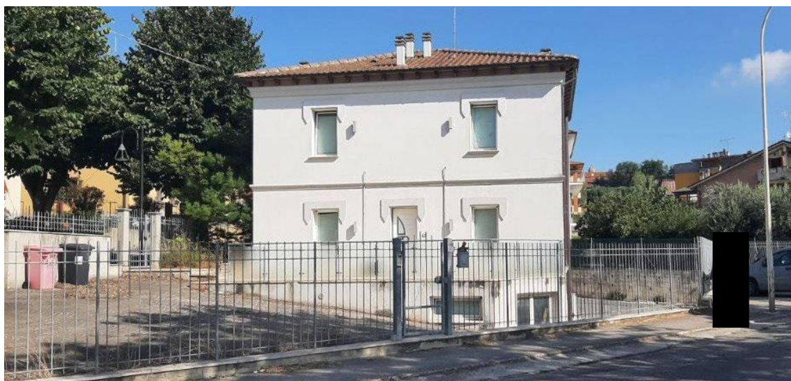
Foto 5 – Vista dello stesso fabbricato sempre da via Vittorio Veneto ma più a valle in corrispondenza dell'incrocio con via Antonio Gramsci; trattasi del prospetto che comprende l'ingresso dell'unità adibita ad ufficio identificata in C.F. al Foglio 12 mapp. 261 sub. 8 e distinta al civico 111 di via A. Gramsci
