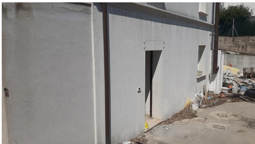
Foto 9 – Vista della porzione al piano interrato del prospetto che affaccia su via V. Veneto (vedi foto 4) che comprende l'ingresso alla unità ad uso ufficio identificata in C.F. al Foglio 12 mappale 216 sub. 7 e distinta al civico 82 di via V. Veneto con relativo cancello pedonale sulla recinzione di confine sulla stessa strada.
