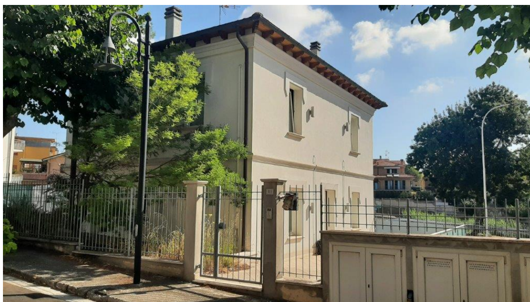
Foto 6 – Vista del fabbricato da via A. Gramsci, in corrispondenza dell'incrocio con via V. Veneto; si evidenzia il cancello pedonale di accesso all'unità di cui sopra al PT.
