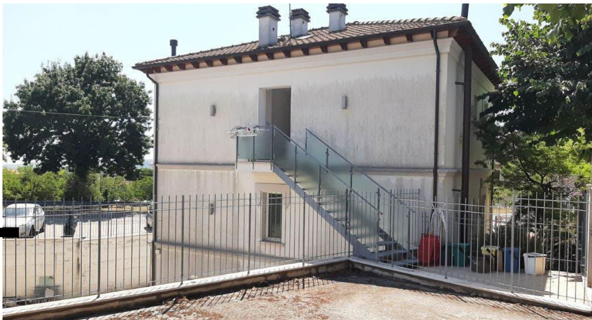
Foto 7 – Vista del fabbricato sempre da via A. Gramsci ma da un punto più a monte; si evidenzia il prospetto opposto che comprende l'accesso alle n. 2 unità residenziali ubicate al piano primo, a mezzo di scala metallica esterna, identificate in C.F. al Foglio 12 mappale 261 sub. 9 e 10 e distinte al civici 109/1 e 109/2 di via A. Gramsci.
