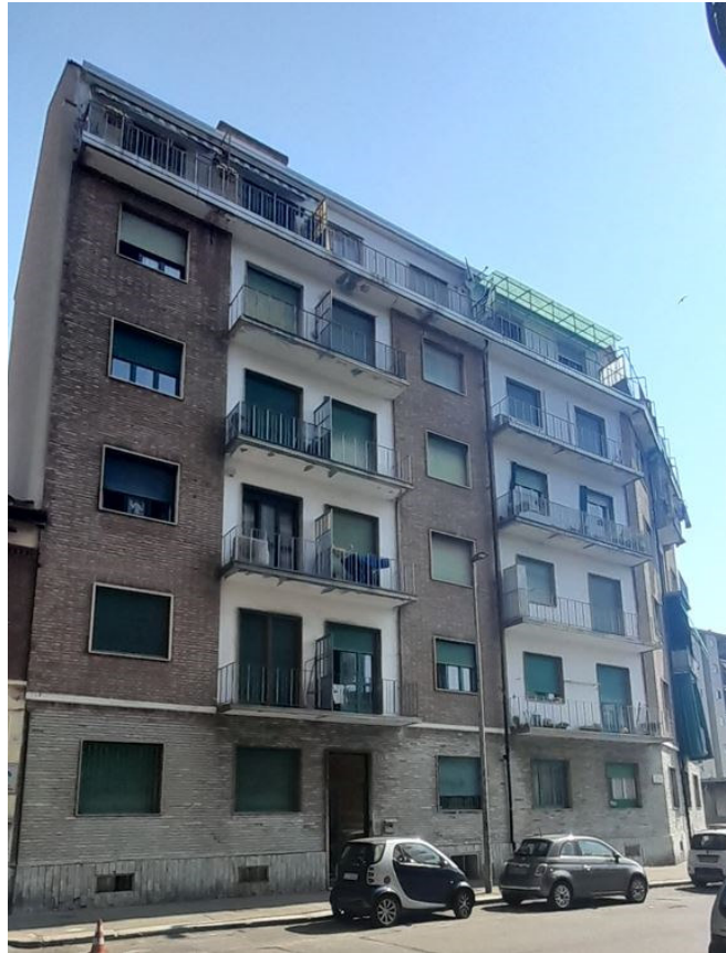
Foto 1- prospetto su strada
