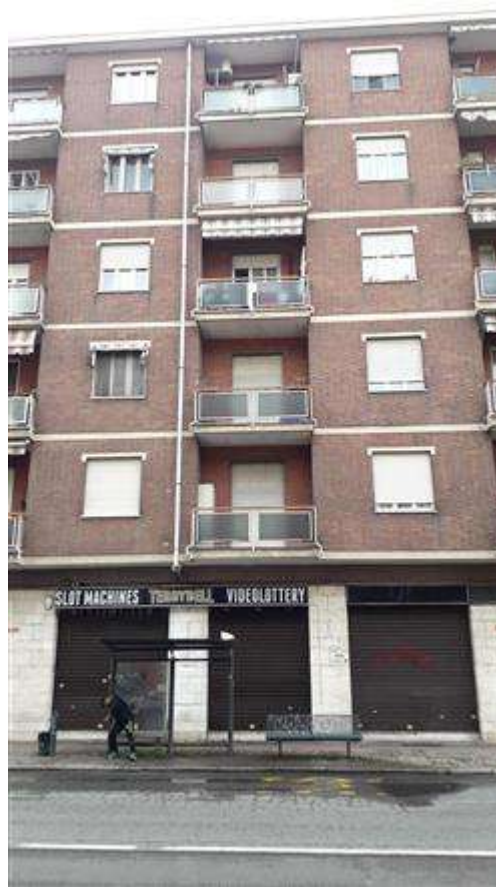
FACCIATA VIA SESTRIERE 54
