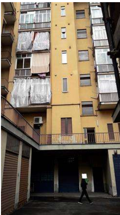
FACCIATA LATO CORTILE
