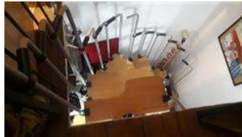
SCALA ACCESSO SOTTOTETTO
