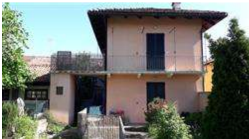
PARTICOLARE LATO SUD
