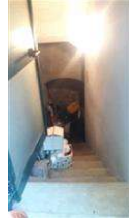
SCALA ACCESSO CANTINA
