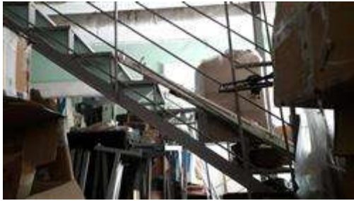
SCALA COLLEGAMENTO PIANO TERRENO TAMPONATA
