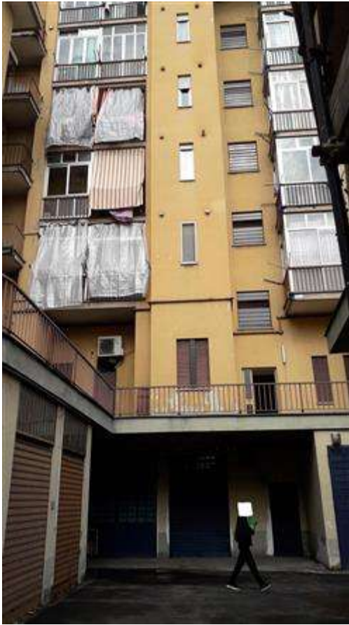
FACCIATA LATO CORTILE
