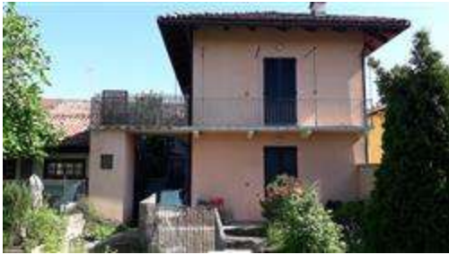
PARTICOLARE LATO SUD
