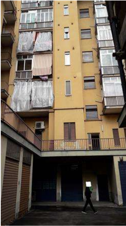
FACCIATA LATO CORTILE
