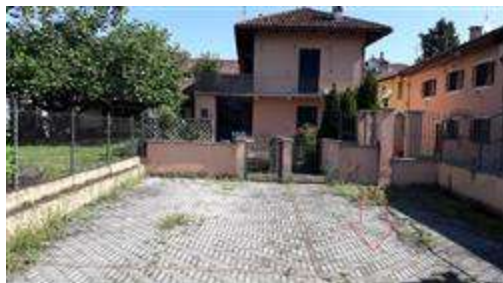
POSTO AUTO (A DESTRA lato strada)
