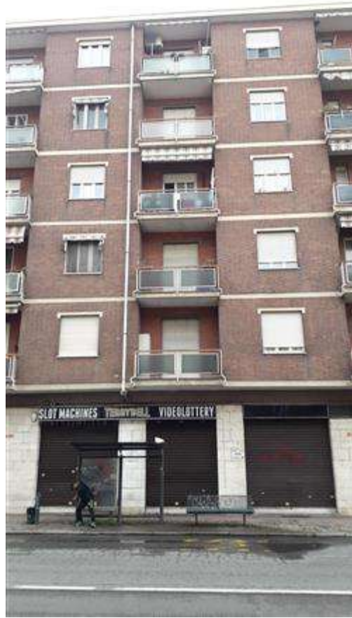
FACCIATA VIA SESTRIERE 54
