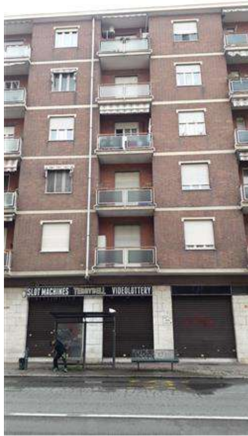
FACCIATA VIA SESTRIERE 54
