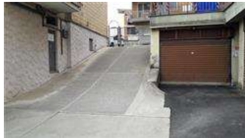
RAMPA ACCESSO AL CORTILE RIBASSATO DA VIA PIAVE 1
