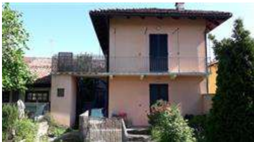
PARTICOLARE LATO SUD
