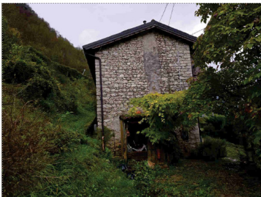
Foto n. 3 - Fg. 81 mapp. 524 - Fabbricato, prospetto nord-ovest
