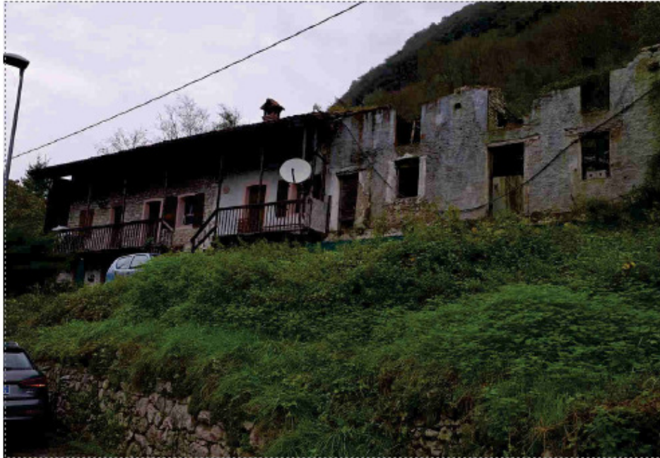
Foto n. 1 - C.F. Fg. 81 mapp. 524 - Fabbricato vista da sud-ovest
