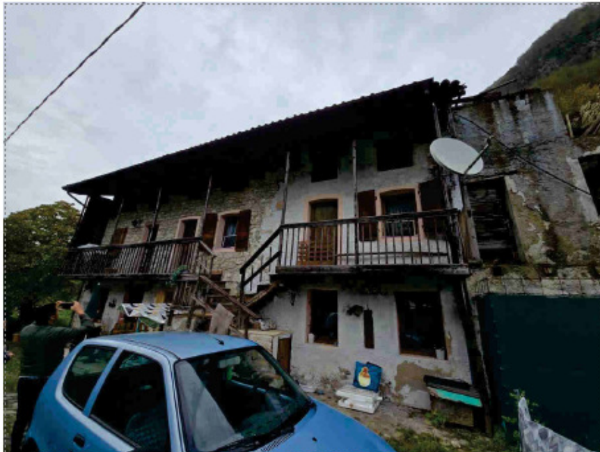
Foto n. 2 - C.F. Fg. 81 mapp. 524 - Fabbricato vista da sud-ovest
