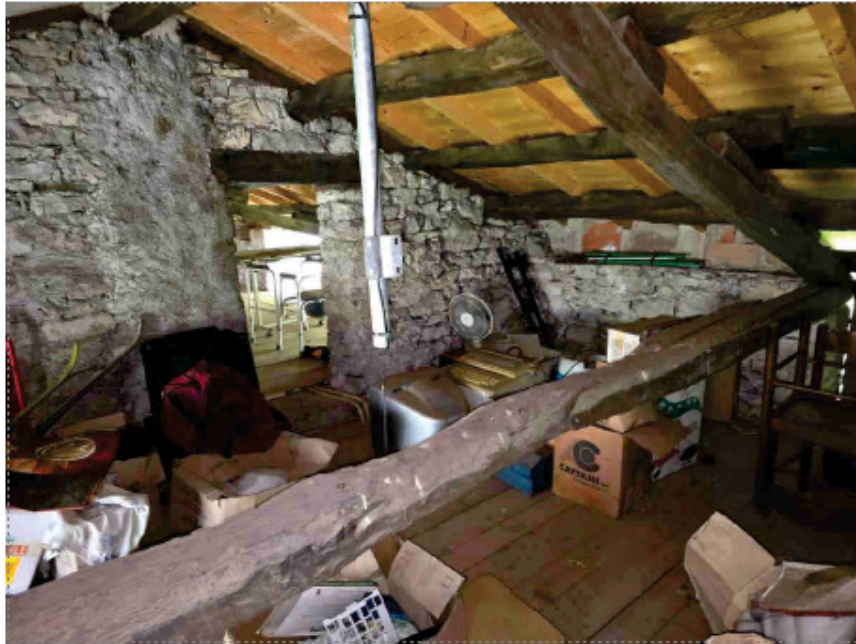
Foto n. 11 - C.F. Fg. 81 mapp. 524 - Piano secondo, soffitta
