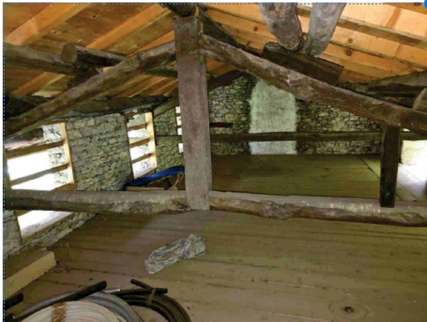
Foto n. 12 - C.F. Fg. 81 mapp. 524 - Piano secondo, soffitta
