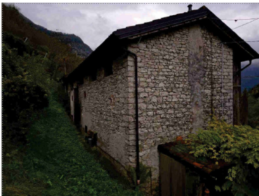
Foto n. 4 - C.F. Fg. 81 mapp. 524 - Fabbricato, prospetti nord-ovest e nord
