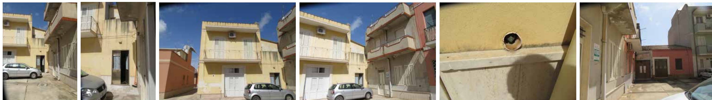
Foto da 225 a 242 - ingresso secondario al bene
