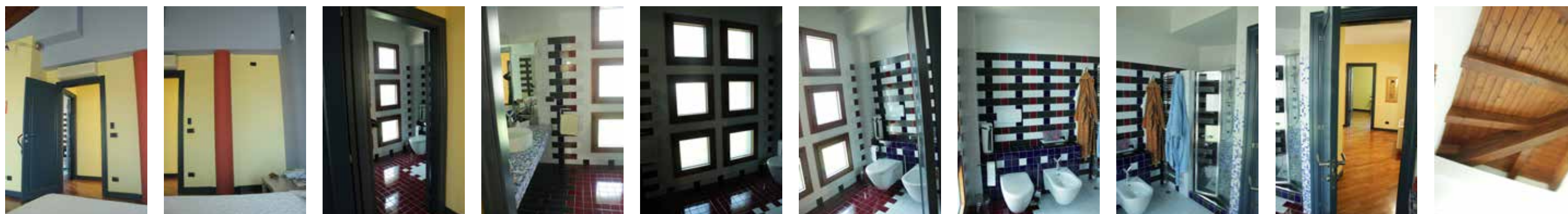
Foto da 392 a 425 - vano A15 bagno
