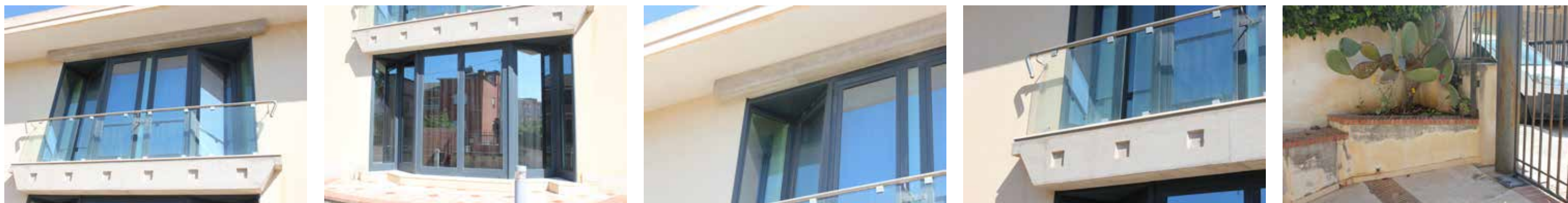
Foto da 116 a 124 - Balcone A13
