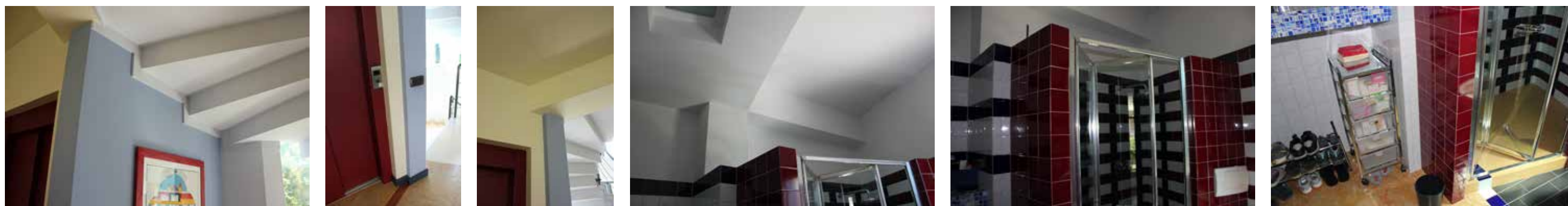
Foto da 248 a 256 - vano A3 bagno
