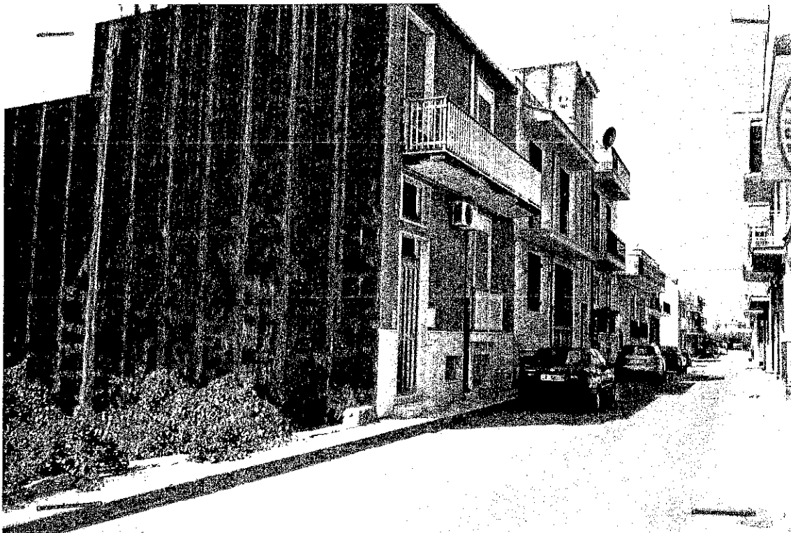
F.1 - Si nota a sinistra il prospetto Est dell'edificio pignorato, coperto da una guaina impermeabilizzante nera. Al centro si nota il prospetto Nord su Via Archimede dell'edificio. Si nota altresì che l'appartamento a p.T. ha il pavimento sotto il livello stradale di Via Archimede.
