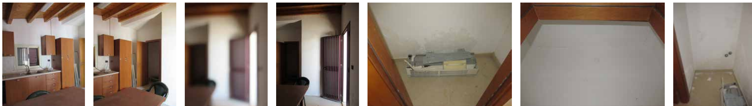
Foto da 101 a 108 - Vano A3 rip
