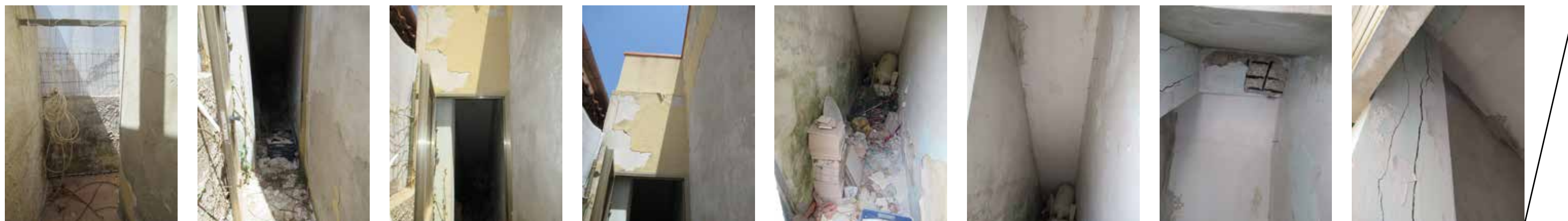
Foto da 62 a 69 - Vano A7 sottoscale
