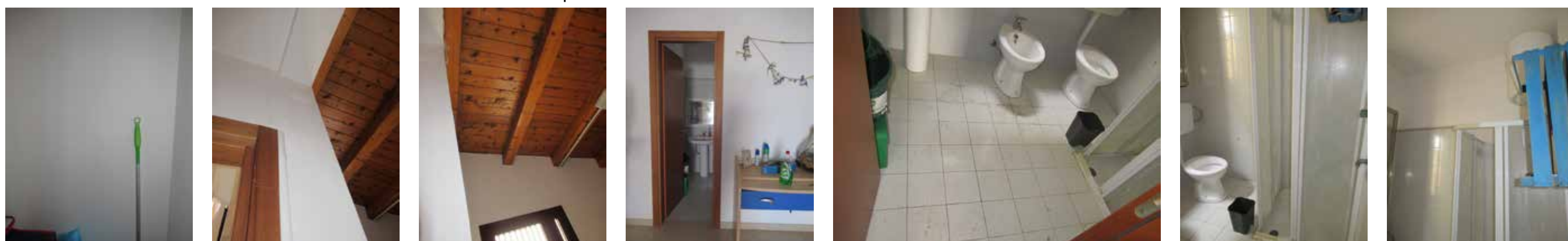
Foto da 37 a 49 - Vano A4 servizio igienico
