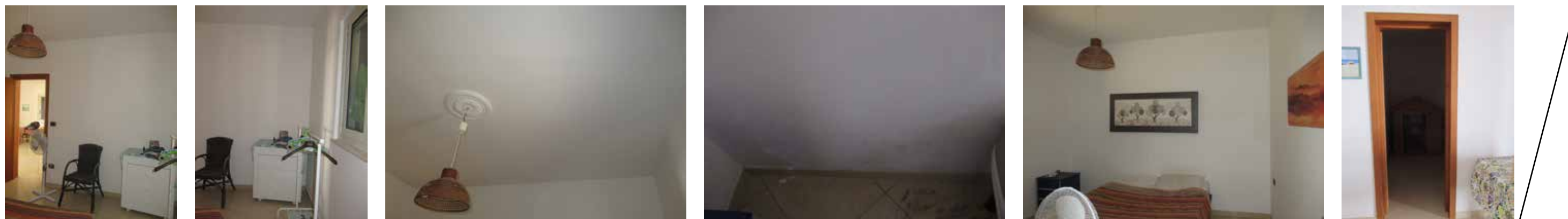
Foto da 64 a 75 - vano A6 camera
