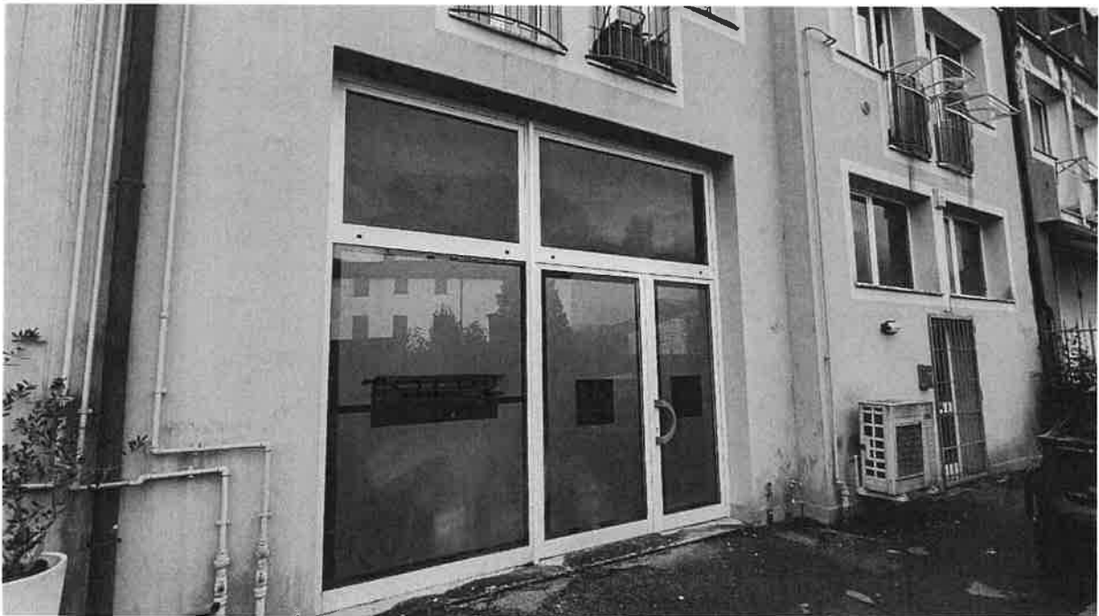
Vista prospetto immobile in oggetto
