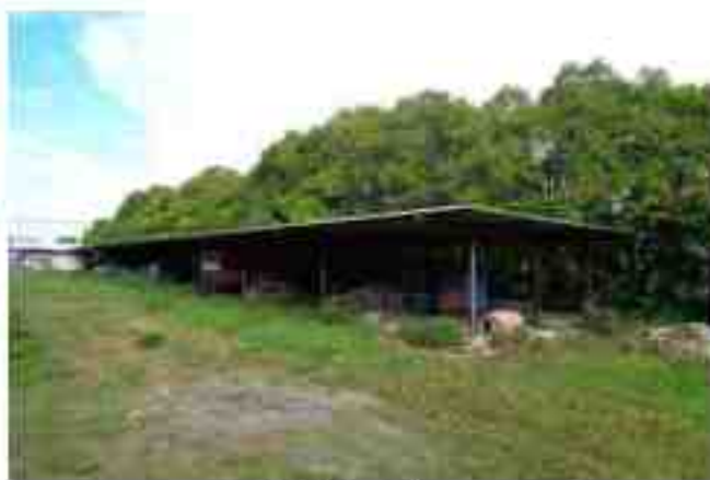
Tettoia lato Sud
