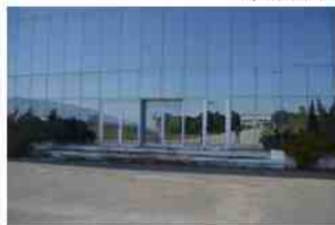
Ingresso - lato Nord
