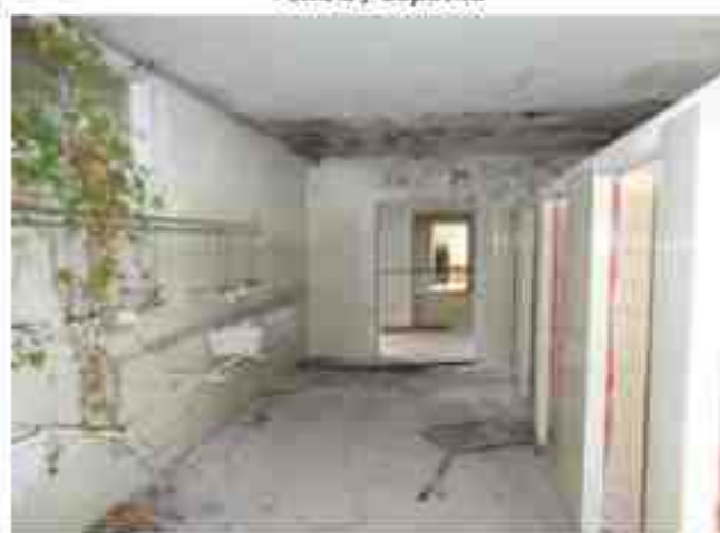
Vista interna – locale doccie
