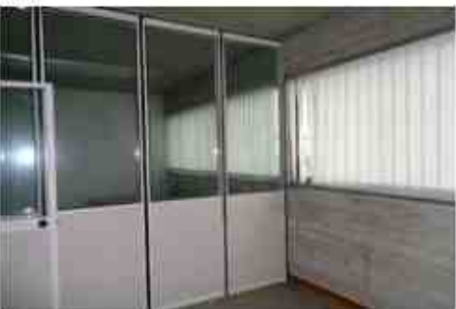
Locali lato Sud
