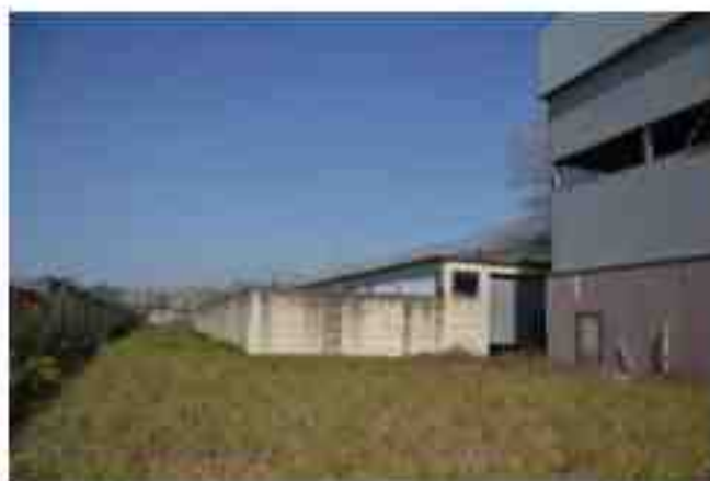
Vasca / magazzino – lato Ovest
