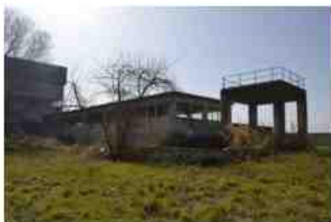
Magazzino / vasche / Ripostigli
