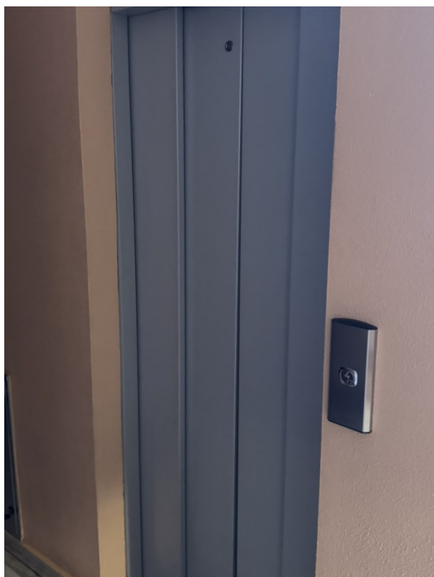
Foto 3: Il vano ascensore condominiale.
