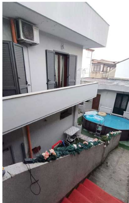
Foto 10. Balcone n.2 (lato cortile)
