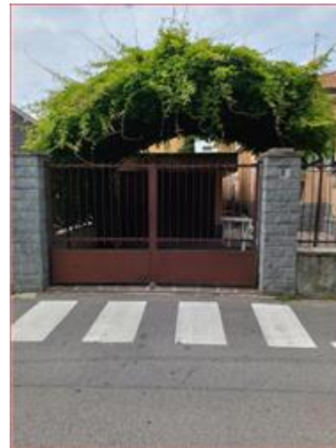
Vista da via Trieste -accesso carroio-
