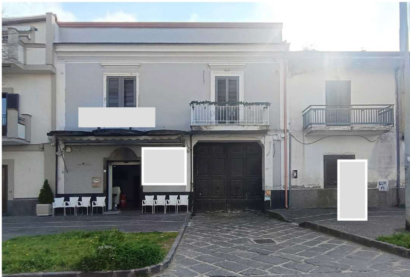
Foto 00. Fabbricato visto da via Roma
