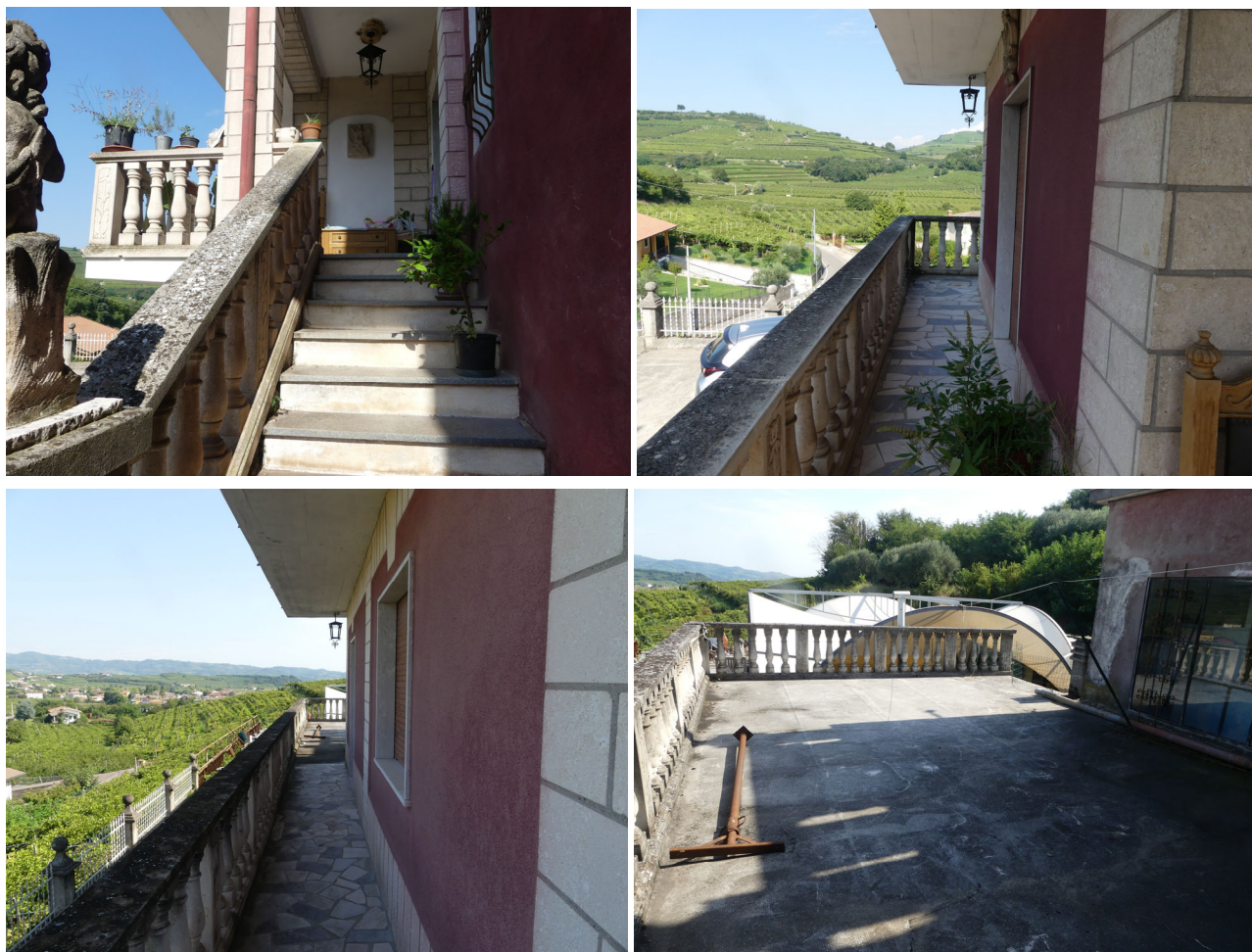
Scala esterna, balconi e terrazzo
