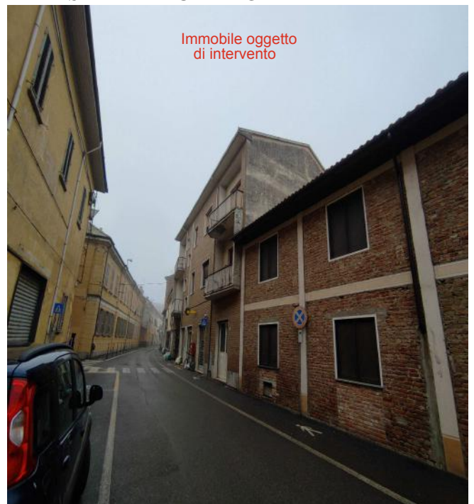
VISTE PRIMA/DOPO FABBRICATO
