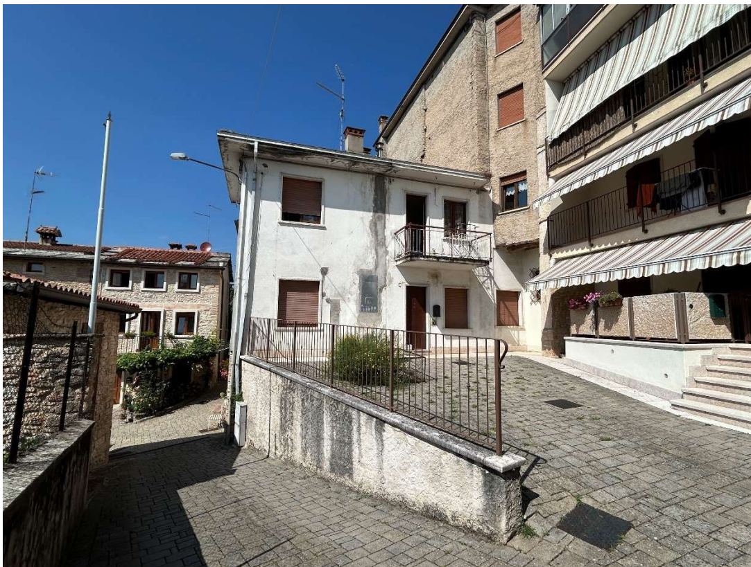
Figura 3: esterni (facciata sud e corte esclusiva)
