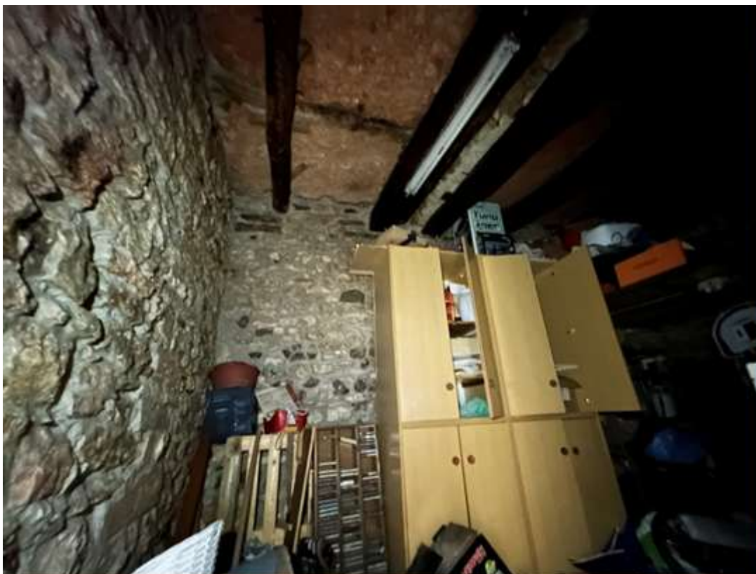
Figura 8: PT ripostiglio (sassi a vista, travi a vista, solaio in pietra, pavimento in pietra, senza finestre)
