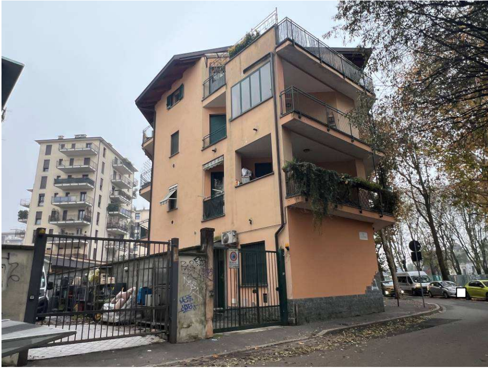
Fotografia n. 2 – Particolare dell'ingresso secondario con cancello pedonale e carroio su Via Sapi e vista del prospetto interno su cui affaccia l'appartamento oggetto della procedura al piano primo (locale ingresso/soggiorno-pranzo/angolo cottura con balcone)
