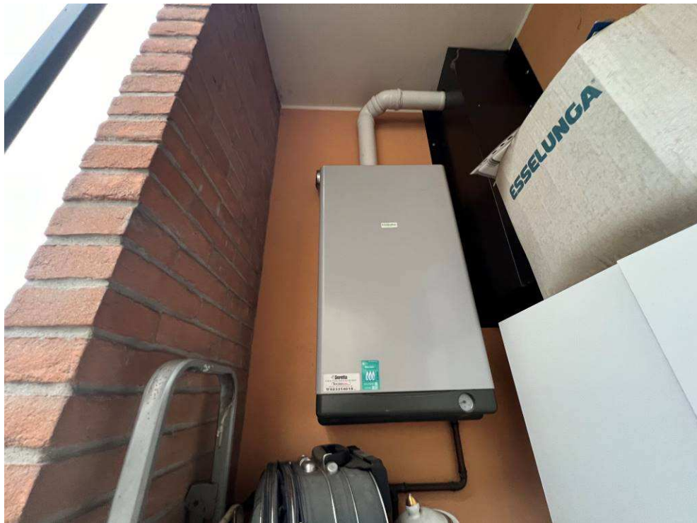
Fotografie n. 28/29 – Vista del balcone, con particolare del serramento del locale camera da letto, con tapparella e inferriata a protezione e della caldaia autonoma a gas marca Beretta, non funzionante
