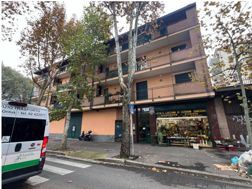
Fotografia n. 5 – Vista del prospetto principale, con accesso su Piazzale Cimitero Maggiore n. 12
