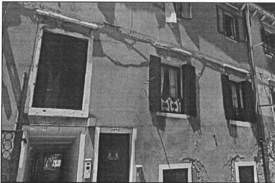
Foto n.9 – Vista entrata del fabbricato da Corte Ferrando
