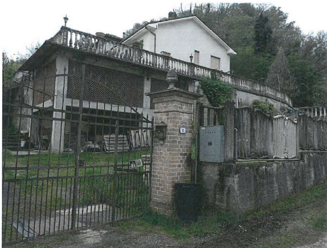
Foto n. 5_ INGRESSO ALLA PROPRIETA' DA VICOLO DEL TUFFO N. 3
